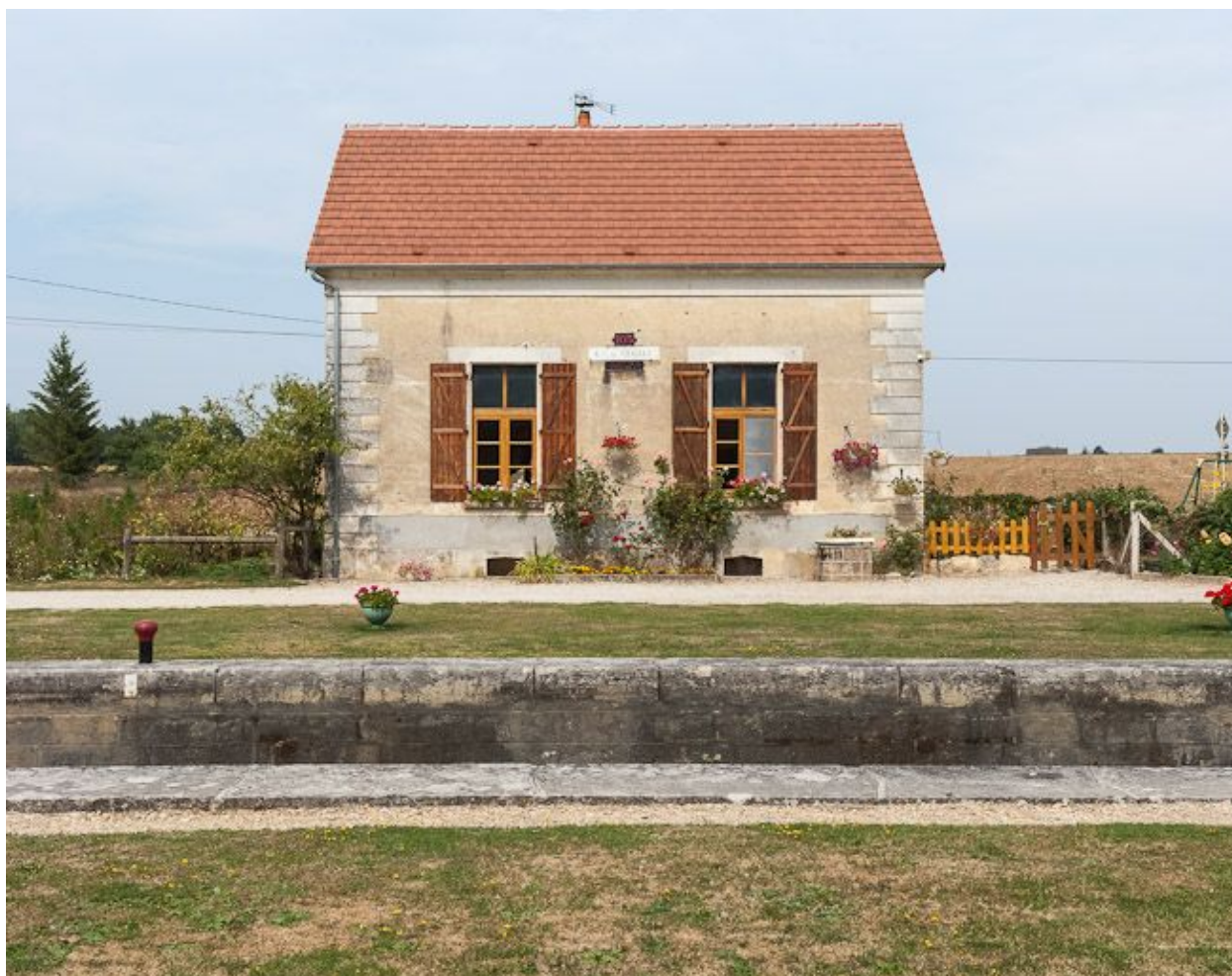
Maison éclusière de face.
