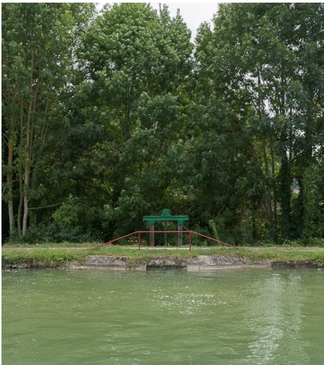
Vanne et déversoir vus du canal.
