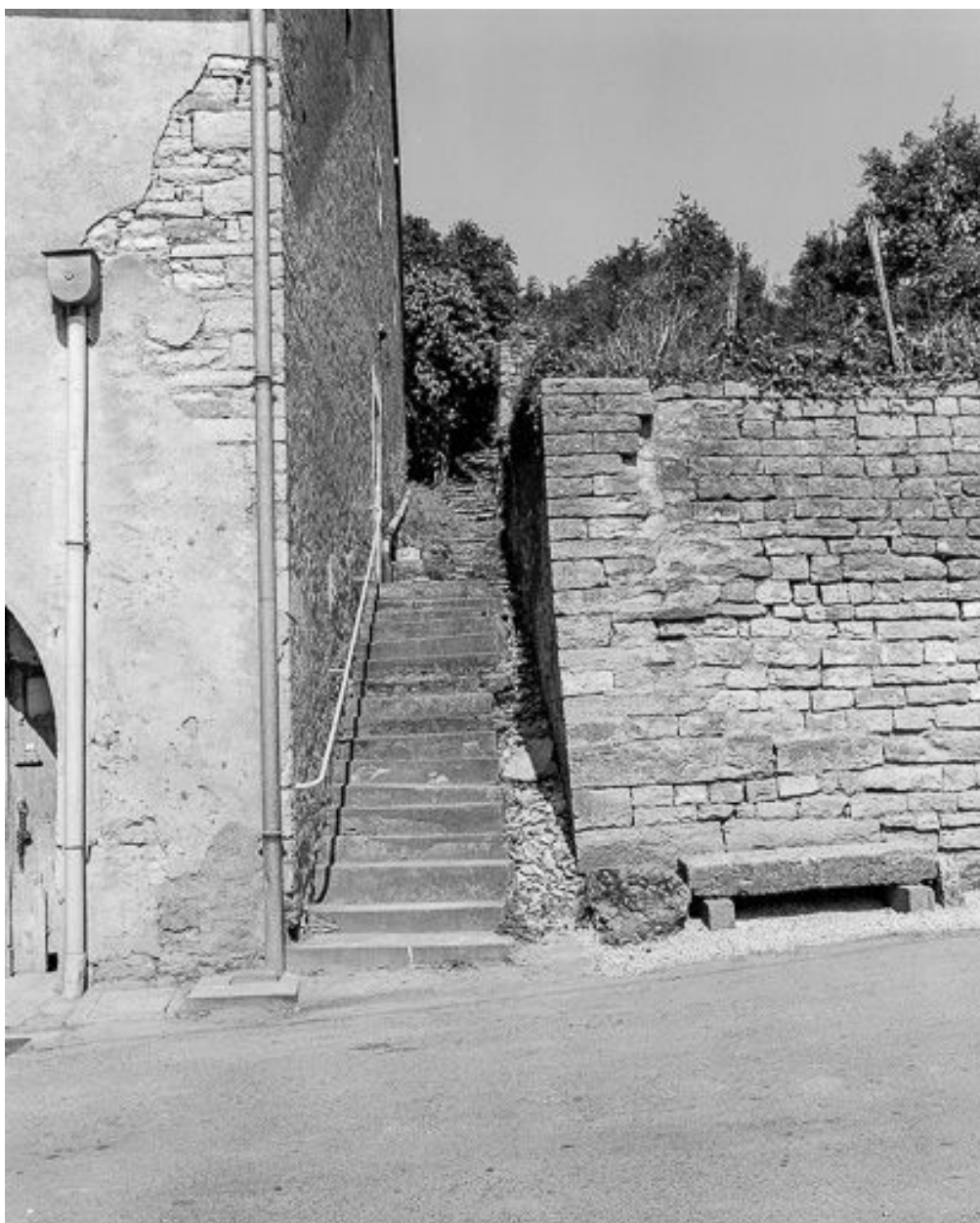
Escalier donnant accès au jardin.
