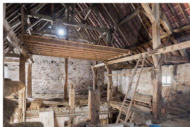
Intérieur de la grange. Phot. Jérôme Mongreville IVR43_20127000713NUC4A
