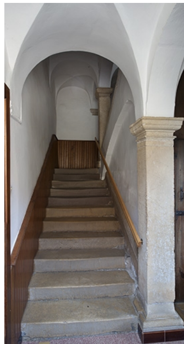
Départ de l'escalier intérieur conduisant à l'étage. Phot. Jérôme Mongreville IVR43_20127000718NUC4A
