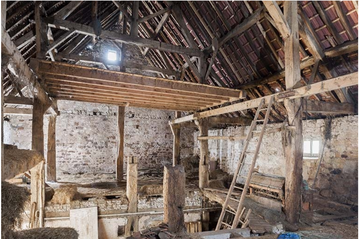
Intérieur de la grange.
