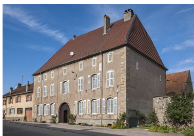
Vue d'ensemble de trois quart droit. Phot. Jérôme Mongreville IVR43_20127000716NUC4A
