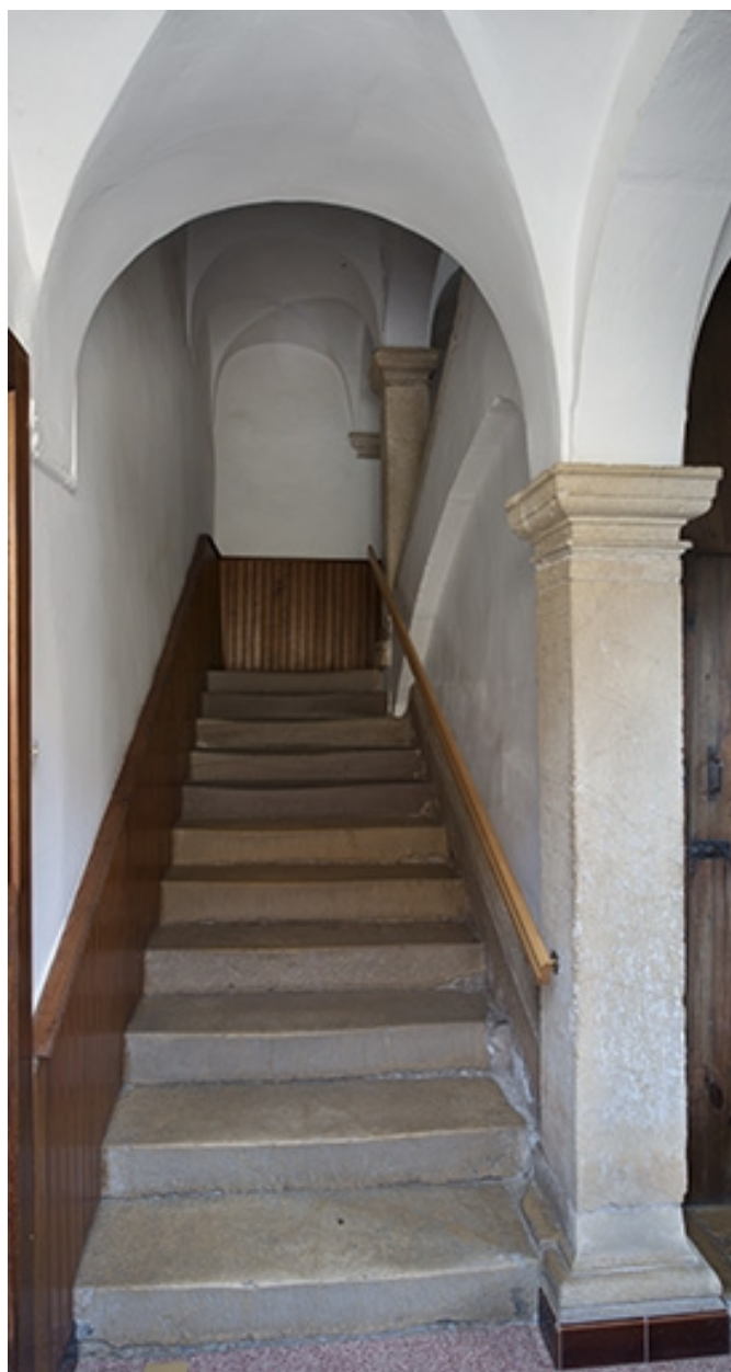
Départ de l'escalier intérieur conduisant à l'étage.
