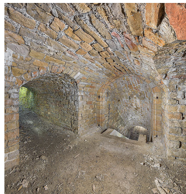
Galerie voûtée menant à la double caponnière. Phot. Thierry Kuntz IVR26_20252100137NUC4A
