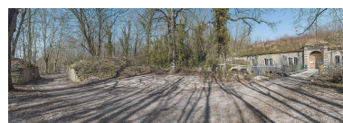
L'accès convexe au fort pour éviter les tirs en enfilade. Phot. Thierry Kuntz IVR26_20252100131NUC4A
