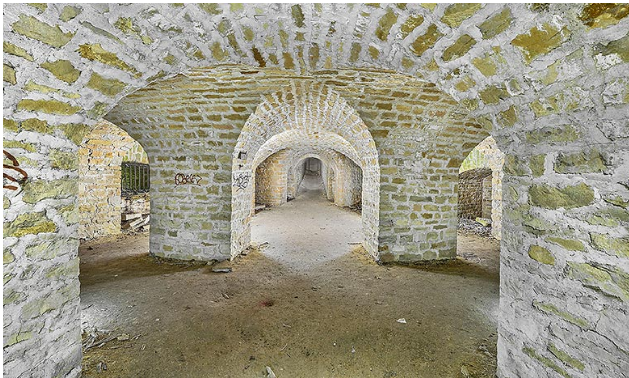
Vue générale de la double caponnière.
