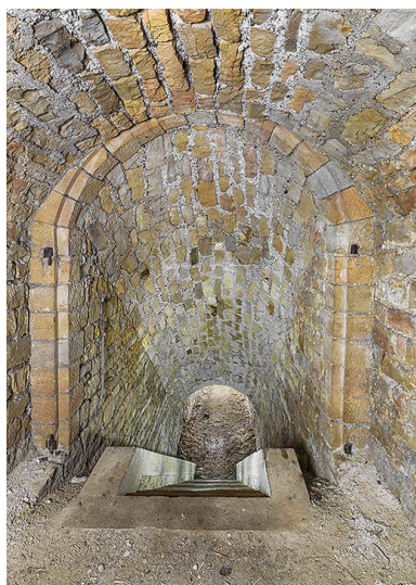
Rampe-escalier vers la double caponnière. Phot. Thierry Kuntz IVR26_20252100138NUC4A
