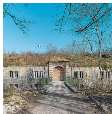
Porte d'entrée du fort : vue générale. Phot. Thierry Kuntz IVR26_20252100423NUC4A
