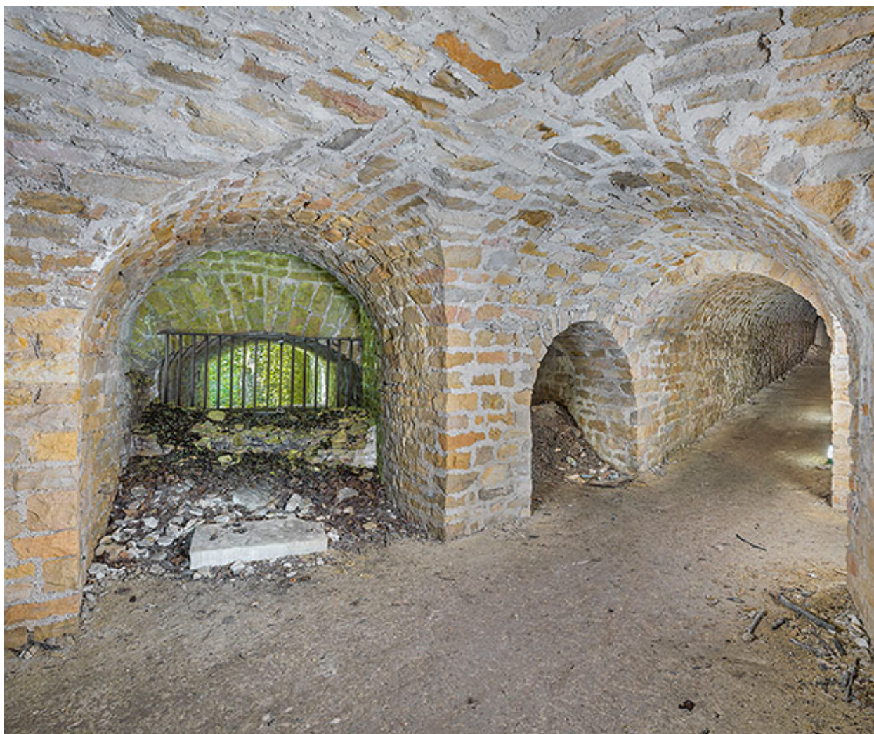
Créneau de tir en direction du fossé.
