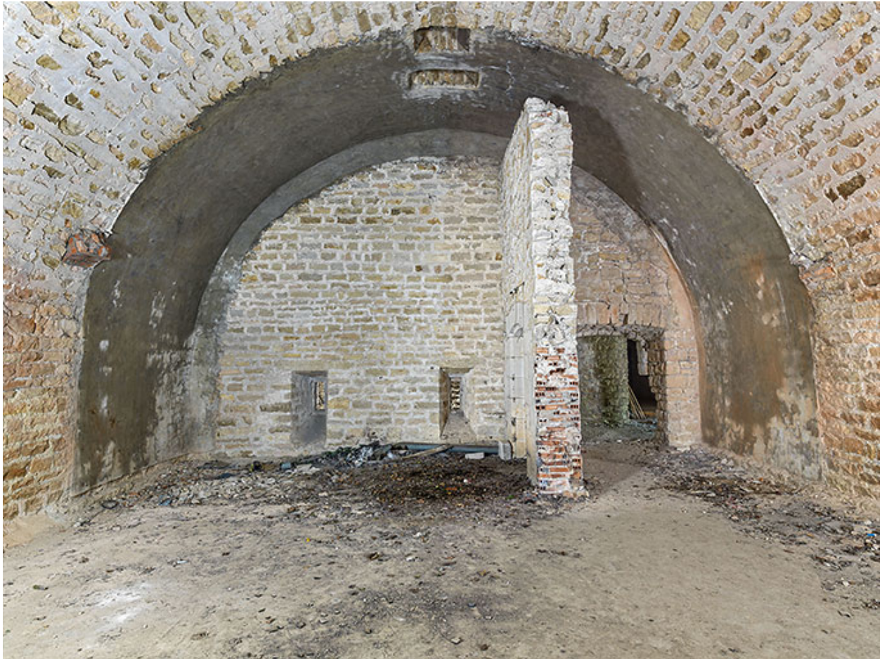
Magasin à poudre : le vestibule d'entrée n'existe plus.
