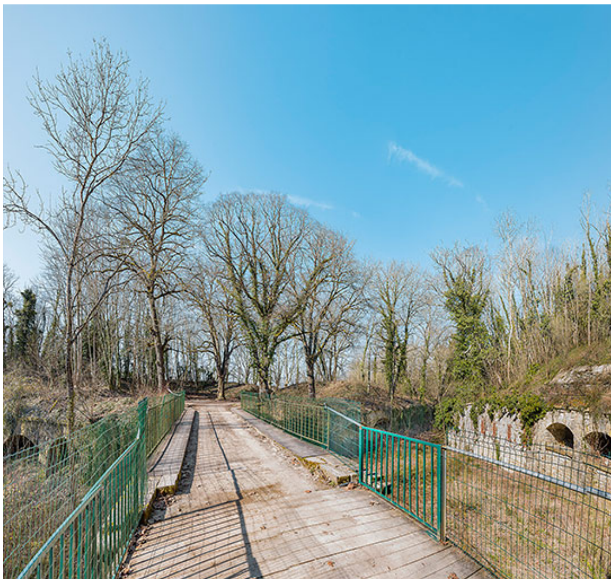
Vue depuis la porte d'entrée. Les coffres de tir à droite.
