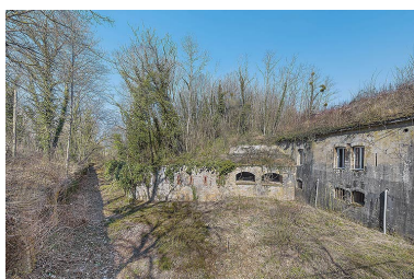
Front de gorge : fossé et coffres de l'escarpe. Phot. Thierry Kuntz IVR26_20252100136NUC4A
