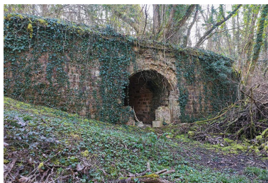
Traverse-abri. (vue aérienne). Phot. Nicolas Douriaux IVR26_20262100367NUC4A
