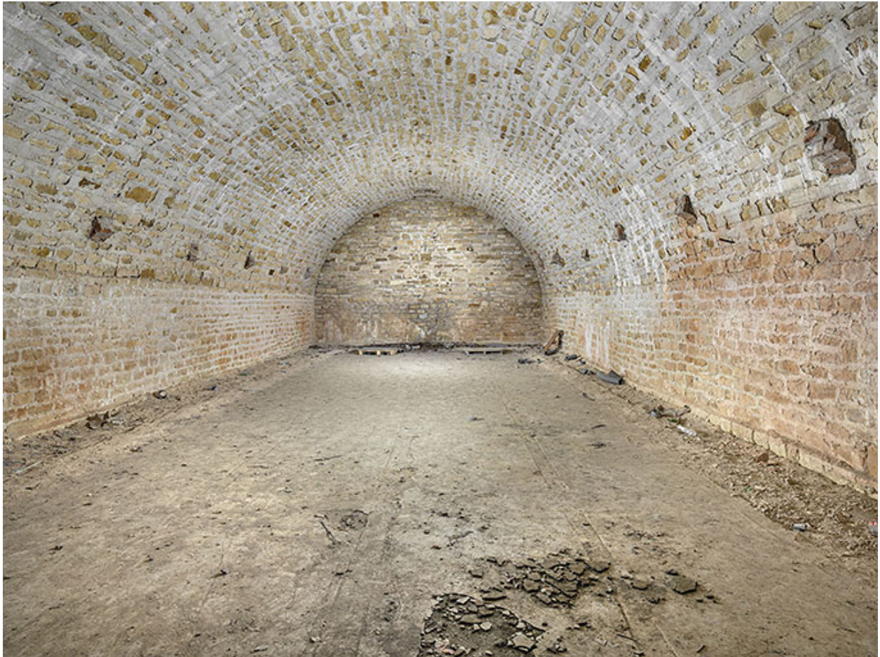
Magasin à poudre : vue d'ensemble.
