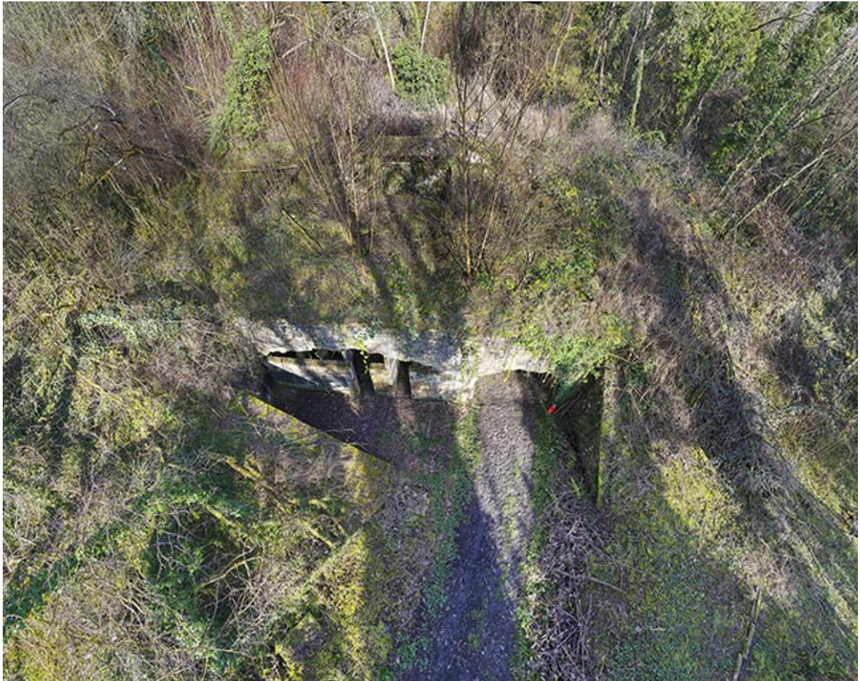
La rue des Remparts : détail de la masse couvrante en terre. (vue aérienne).
