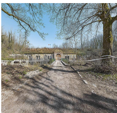
Front de gorge, vue d'ensemble. Phot. Thierry Kuntz IVR26_20252100130NUC4A
