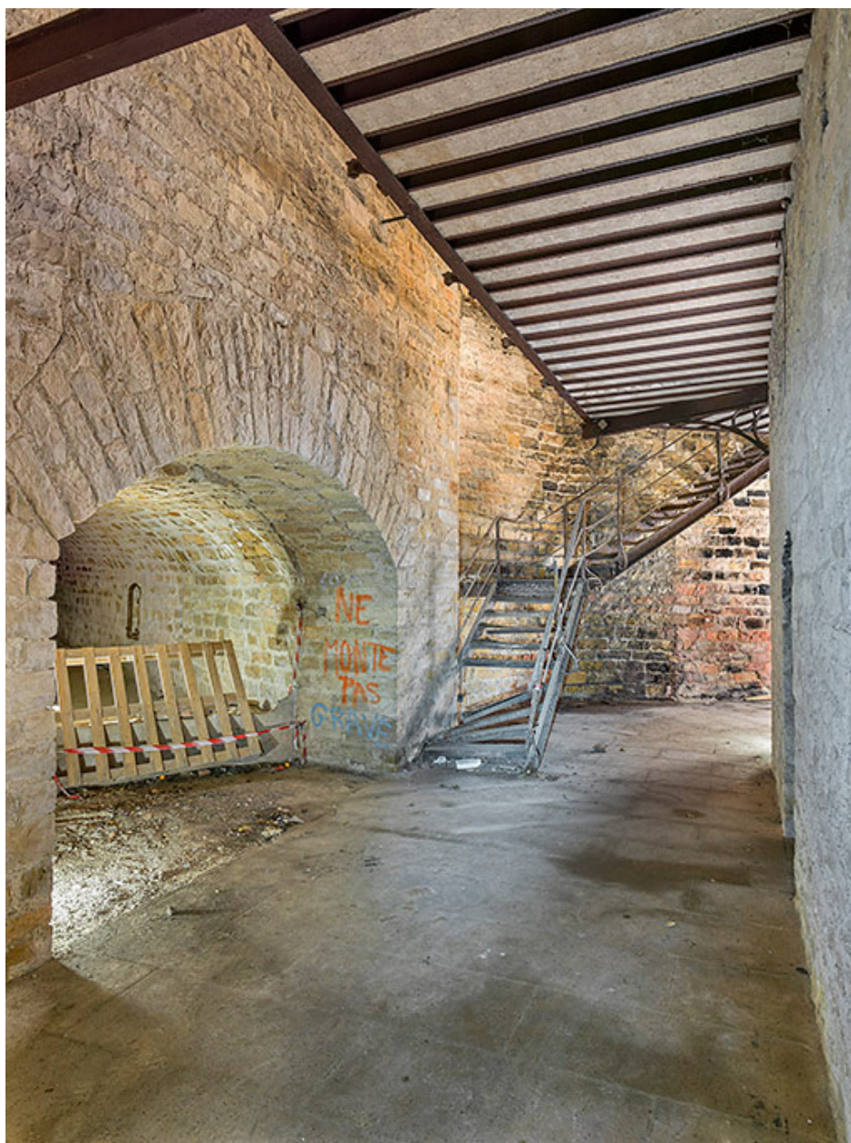
Escalier distribuant l'étage de la caserne.
