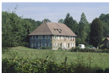
Le moulin. Phot. Yves Sancey IVR43_19999000102ZA
