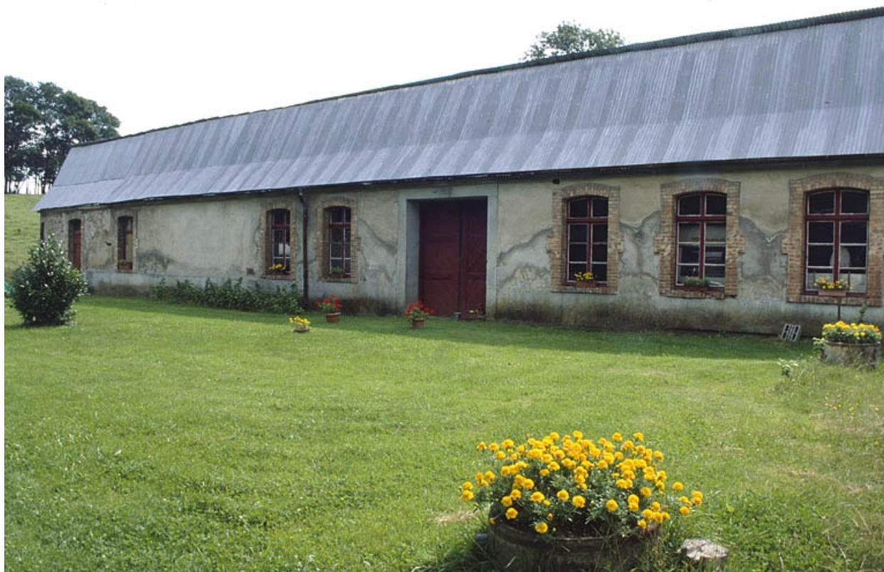
Façade (remaniée) de l'atelier de fabrication.
