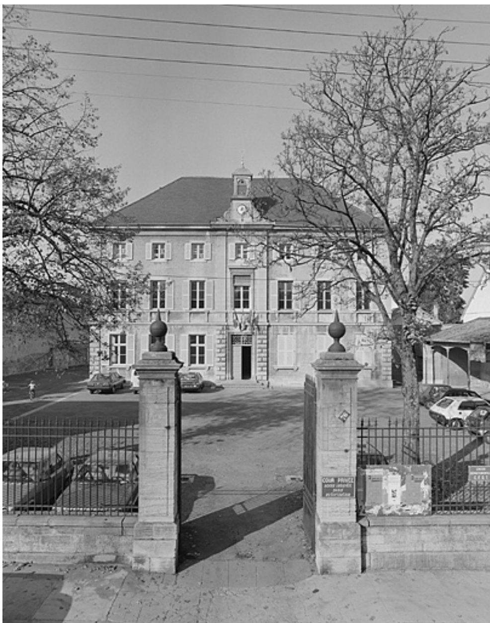
Ecole, 76 rue Saint-Désiré, vue d'ensemble.
