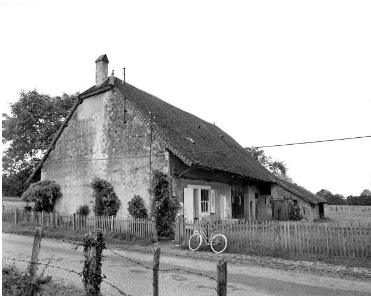
Façades antérieure et latérale gauche.
