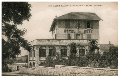
Vue ancienne. Autr. auteur inconnu IVR26_20195800233NUC4A
