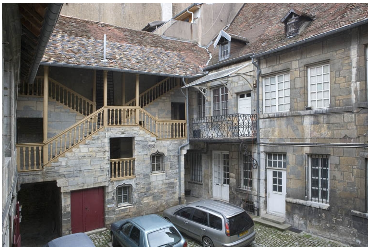
Vue d'ensemble de l'escalier à cage ouverte.
