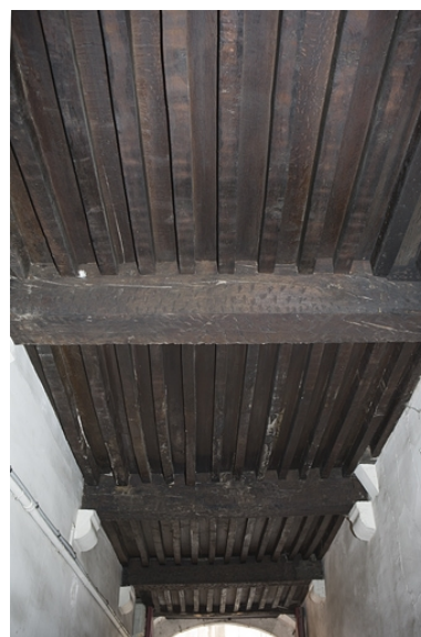
Détail du plafond à la française du passage cocher. Phot. Yves Sancey IVR43_20092501357NUC2A
