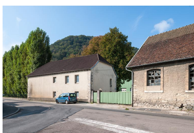
Ancienne conciergerie vue de trois quarts. Phot. Jérôme Mongreville IVR43_20142501130NUC4A
