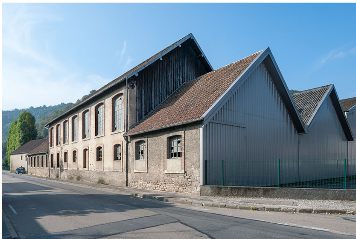
Atelier de fabrication depuis le nord-est.
