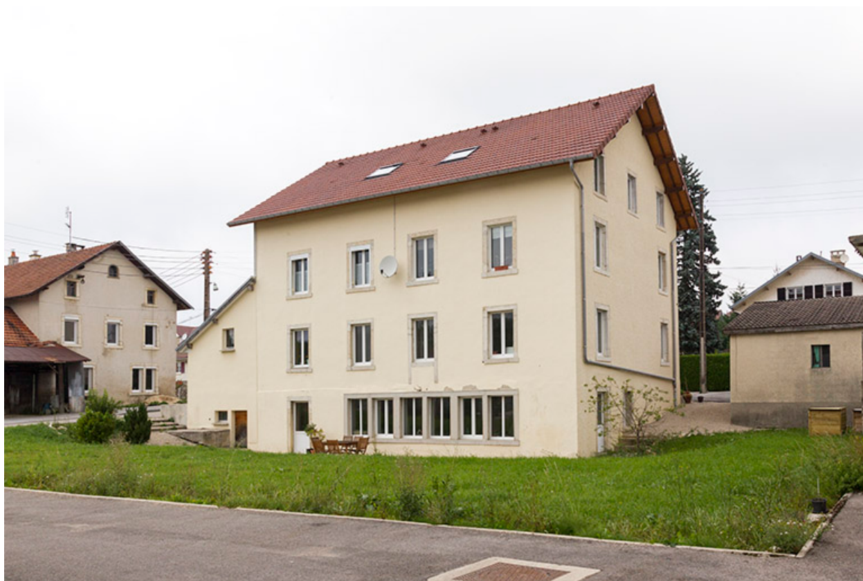
Façades postérieure et latérale droite.
