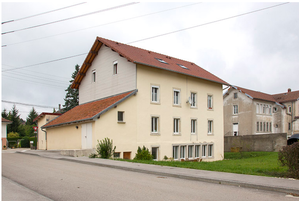
Façades postérieure et latérale gauche.
