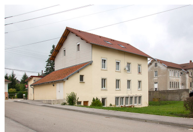
Façades postérieure et latérale gauche.
