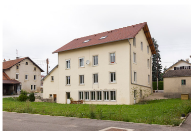
Façades postérieure et latérale droite.
