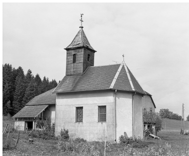
Vue extérieure : abside et face latérale droite. Phot. Dominique Humbert IVR43_19762500303X
