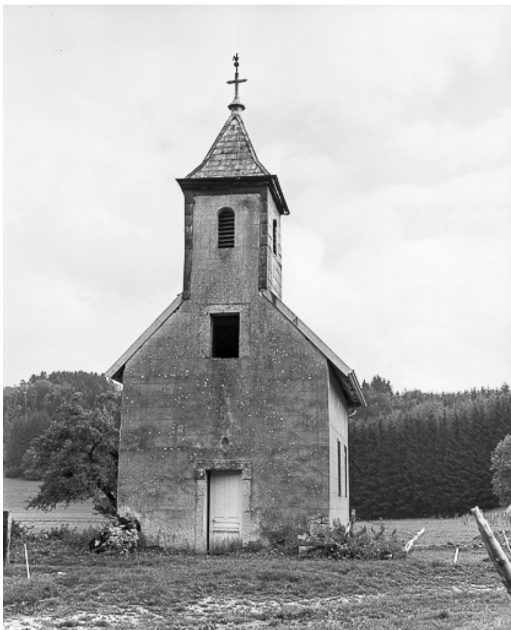
Vue extérieure : façade antérieure.
