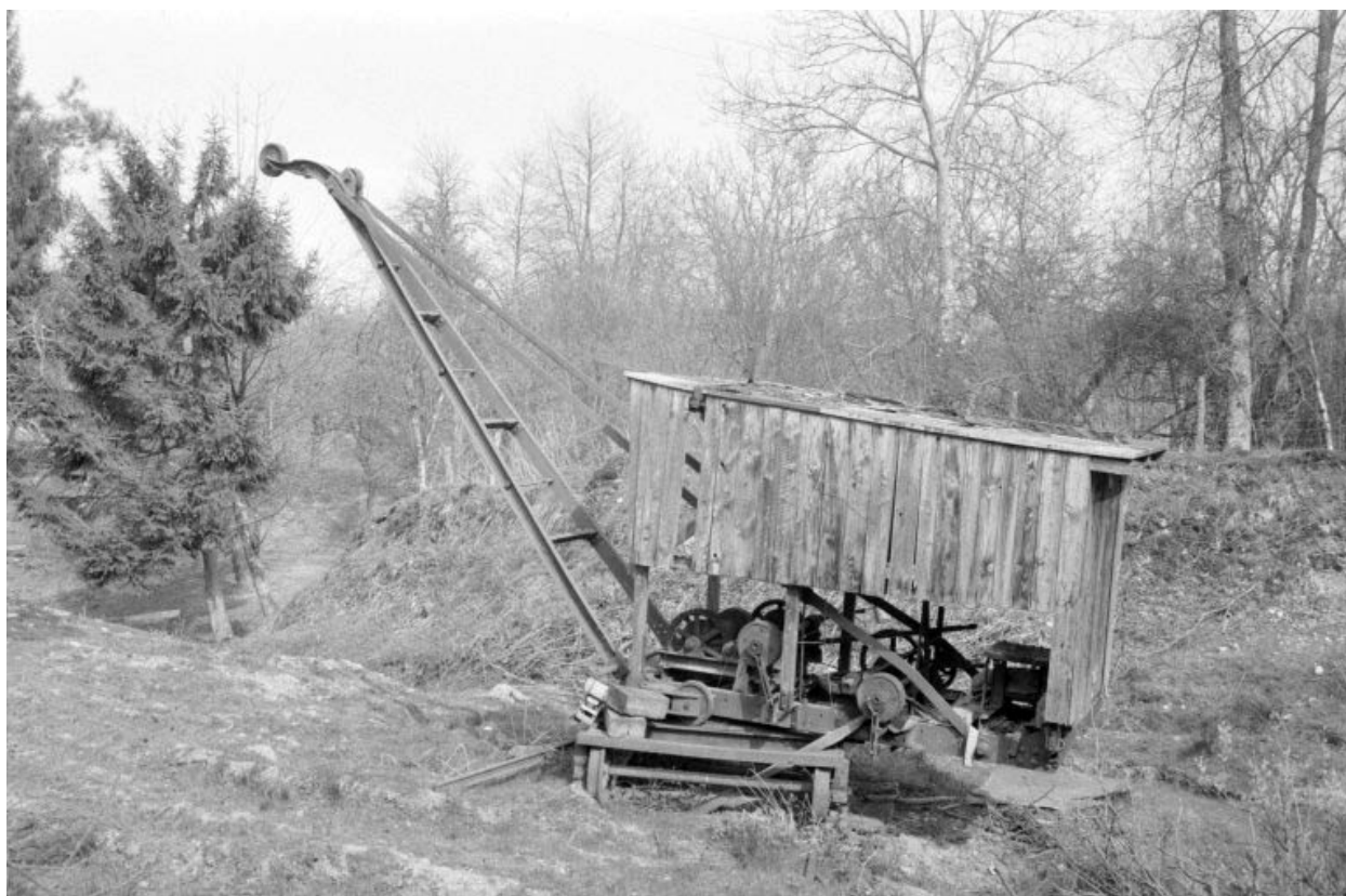
Grue sur voie étroite dans l'ancienne carrière.
