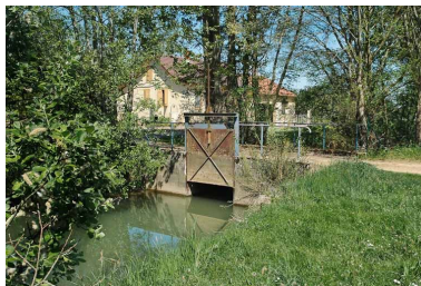
Vue d'ensemble : vanne. Phot. Jean-Luc Duthu IVR26_20107100537NUC2A
