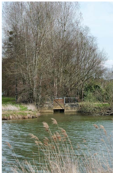
Vue d'ensemble : vanne. Phot. Jean-Luc Duthu IVR26_20107100538NUC2A
