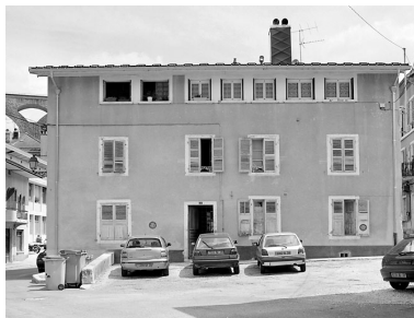
Elévation antérieure. Phot. Yves Sancey IVR43_20033900119X
