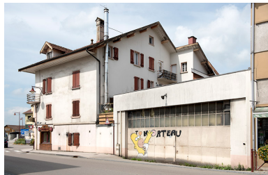
Façade latérale droite. Phot. Sonia Dourlot IVR43_20182500948NUC4A
