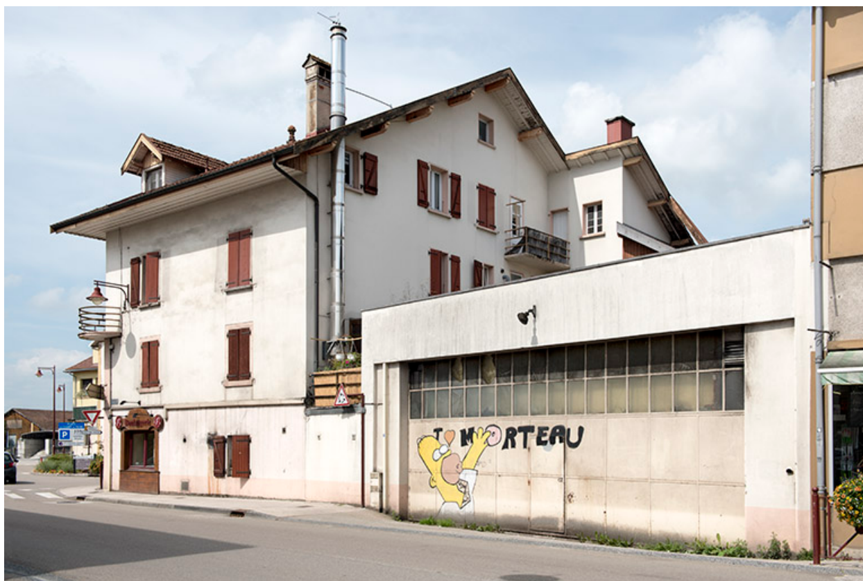
Façade latérale droite.
