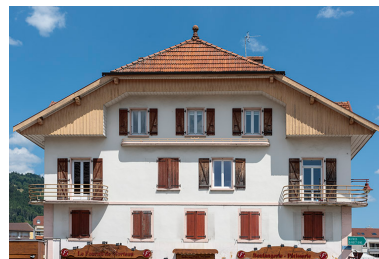
Façade antérieure : étages. Phot. Sonia Dourlot IVR43_20182501250NUC4A
