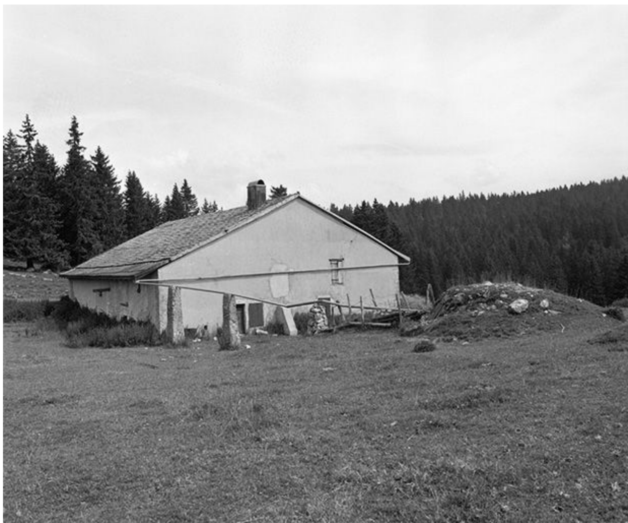
Façades postérieure et latérale gauche.
