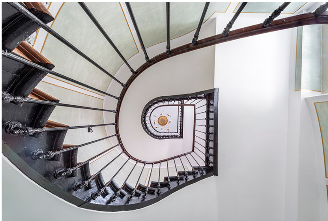
L'escalier principal (aile sud) depuis le rez-de-chaussée.
