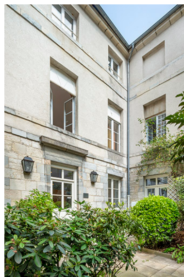
Aile sud vue depuis l'entrée. Phot. Jérôme Mongreville IVR43_20233900636NUC4A
