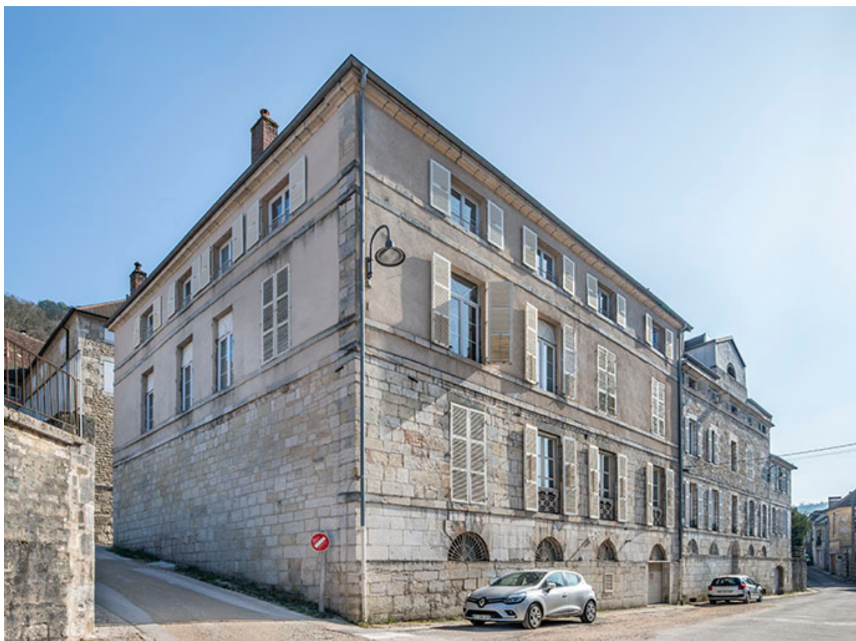
Vue de trois quarts, depuis le nord-ouest.
