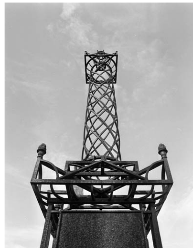
Détail de la colonne en contre-plongée. Phot. Yves Sancey IVR43_19907000039X
