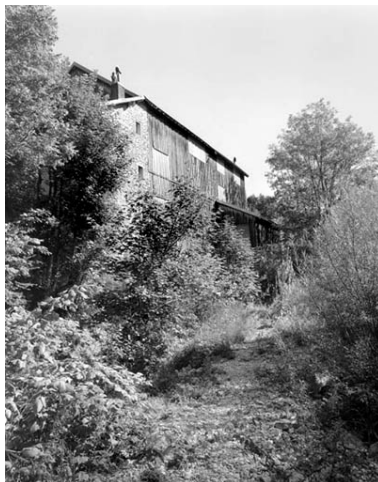
Façade sur l'Ain de l'atelier de fabrication.
