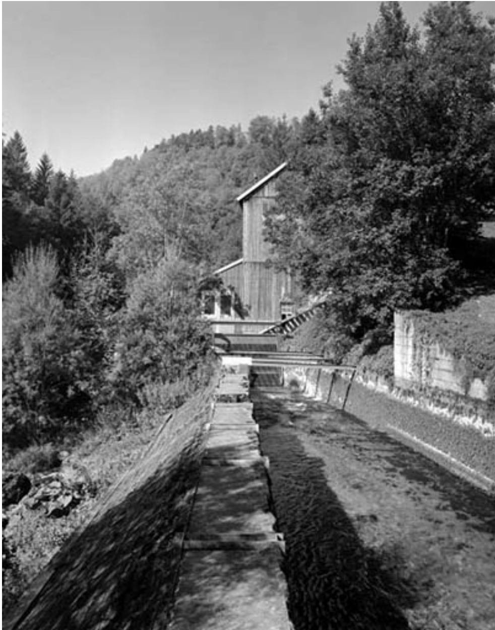
Canal d'amenée de la centrale hydroélectrique.
