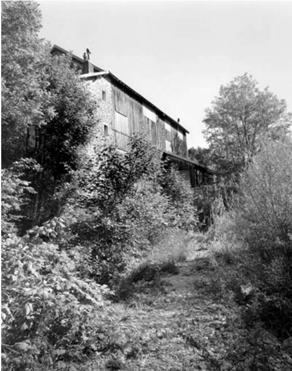
Façade sur l'Ain de l'atelier de fabrication.
