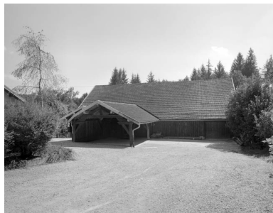
Façade nord de l'atelier de fabrication.
