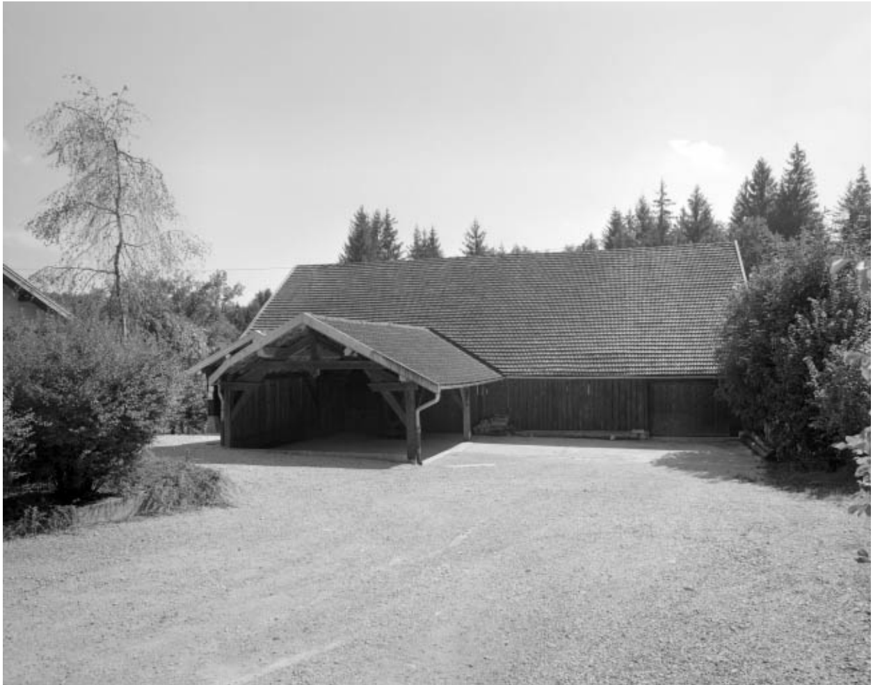
Façade nord de l'atelier de fabrication.
