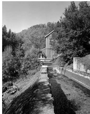
Canal d'amenée de la centrale hydroélectrique.
