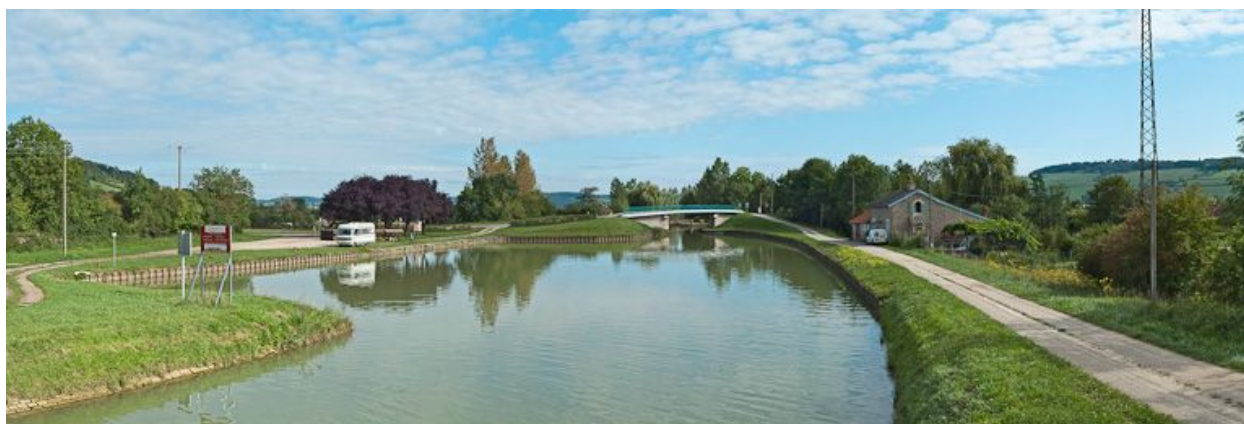
Vue d'ensemble du port.
