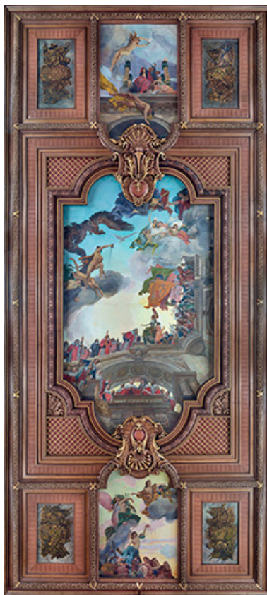
Vue d'ensemble du plafond.
