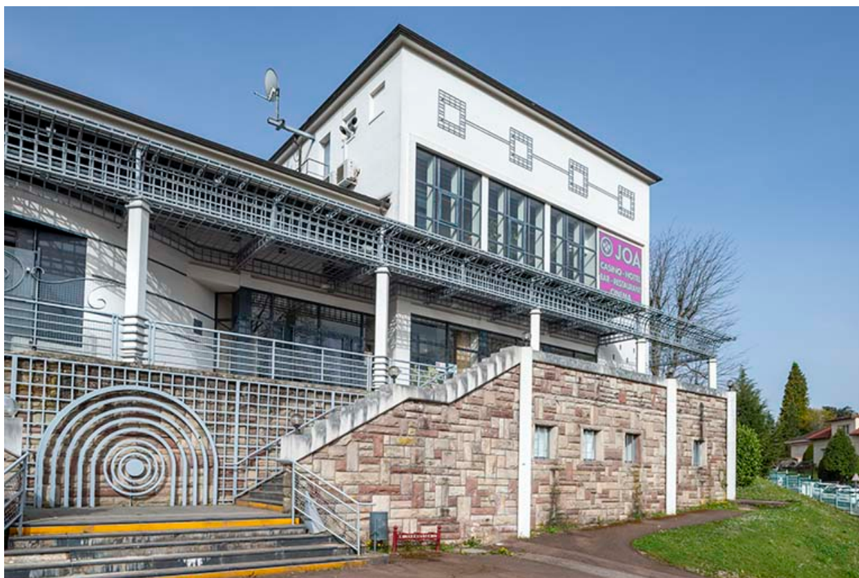
Salle des fêtes, vue depuis le sud-ouest.
