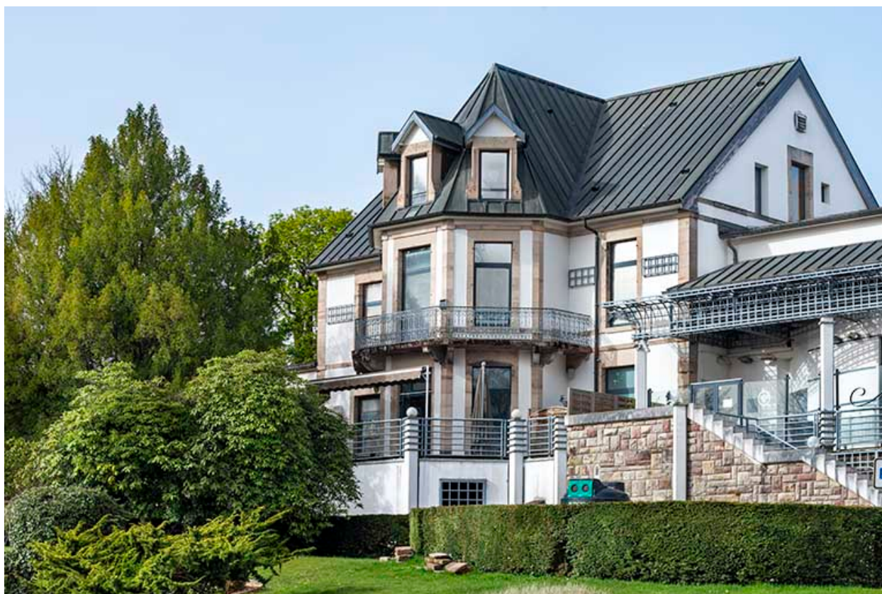
Maison, vue depuis le nord.
