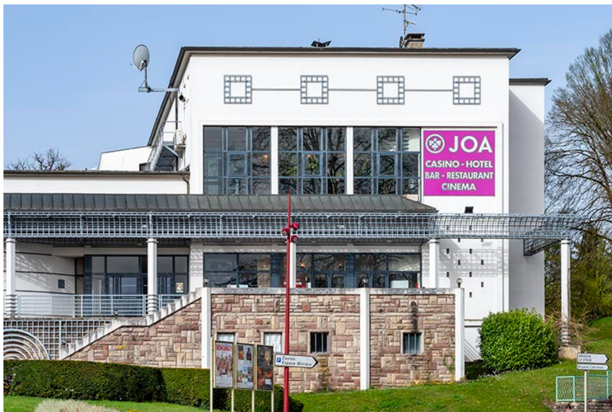
Salle des fêtes, vue depuis l'ouest.
