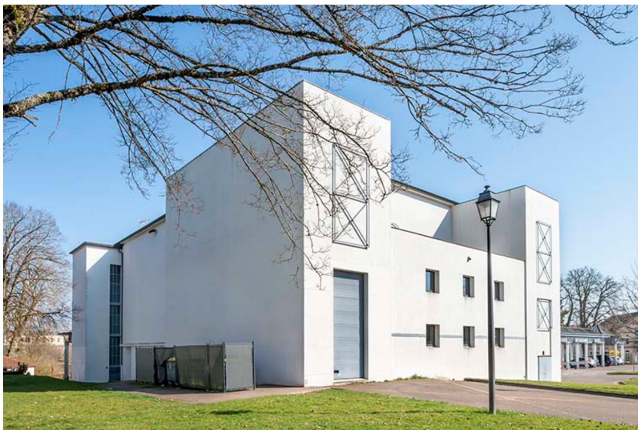
Salle des fêtes, vue depuis le nord-ouest.
