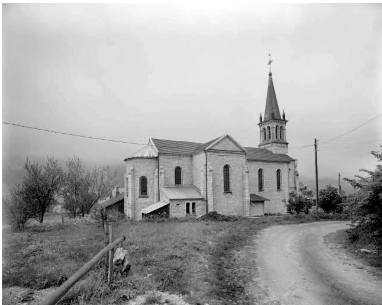
Façade latérale gauche et chevet de l'église.
