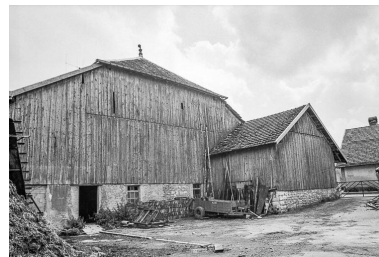
Pignon postérieur de la partie agricole. Phot. Liliane Hamelin IVR43_19752501495Z
