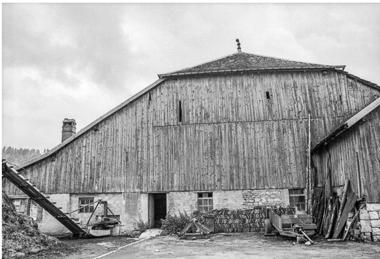
Pignon postérieur de la partie agricole.
