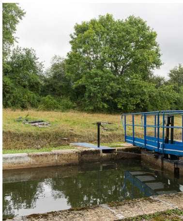
Vue du sas. Phot. Pierre-Marie Barbe-Richaud IVR26_20175800282NUC2A
