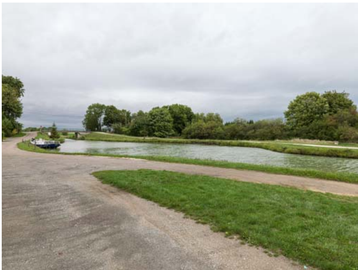
Vue d'ensemble de la gare d'eau.
