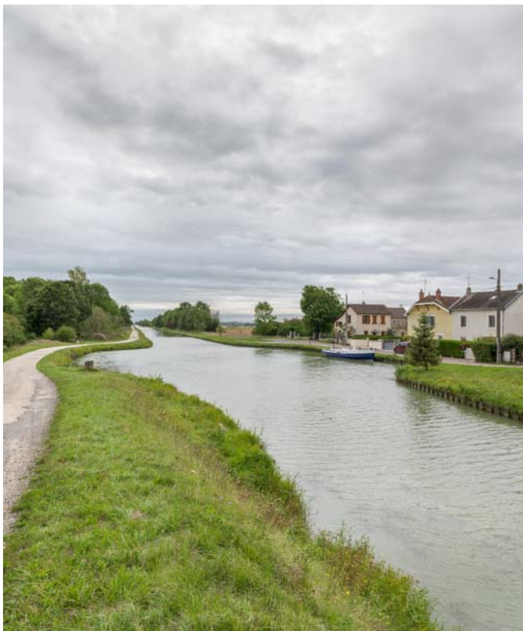
Vue d'ensemble de la gare d'eau.
