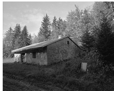
Façade antérieure et face et nord-est. Phot. Jérôme Mongreville IVR43_19963901348X
