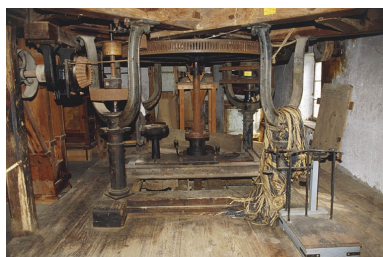
Beffroi de moulin. Phot. Yves Sancey IVR43_20009000131ZA
