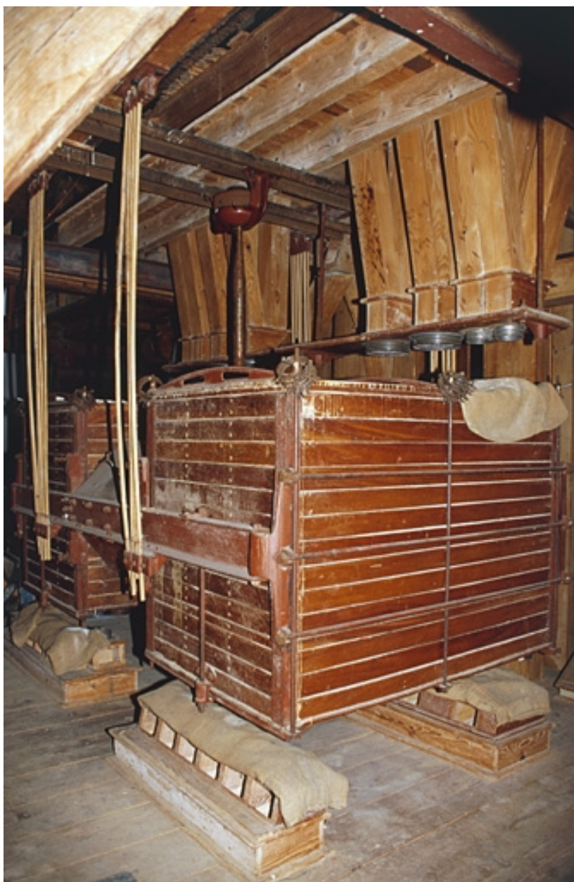
Planschter Lafon à l'étage en surcroît.
