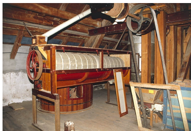
Bluterie à l'étage en surcroît. Phot. Yves Sancey IVR43_20009000137ZA
