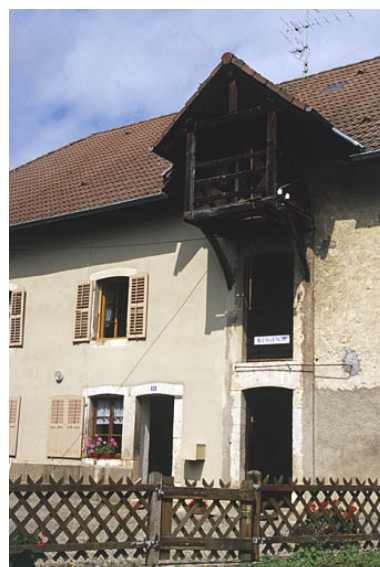
Logement accolé à la minoterie. Phot. Yves Sancey IVR43_20009000129ZA
