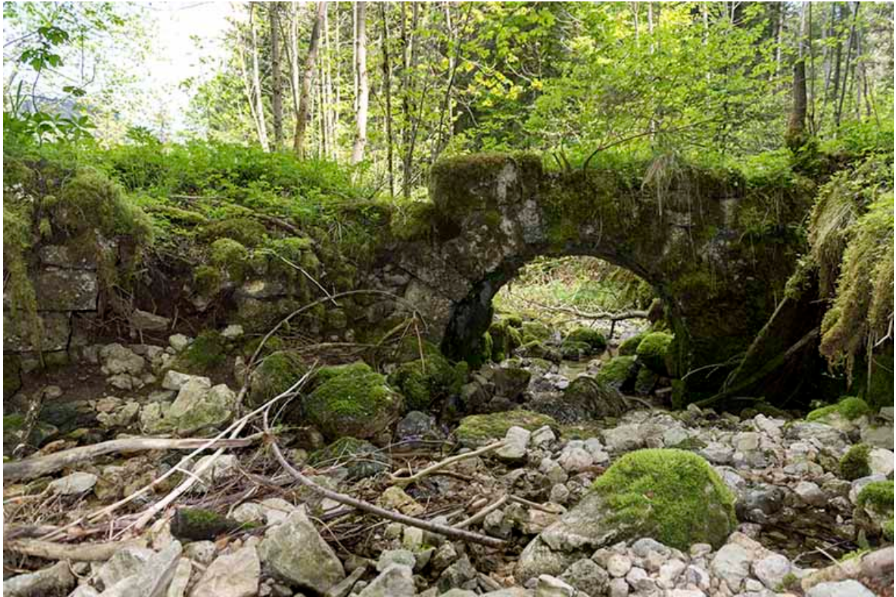
Pont en ruine.
