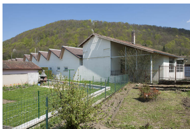
Atelier vu de trois quarts arrière. Phot. Jérôme Mongreville IVR43_20132500228NUC4A
