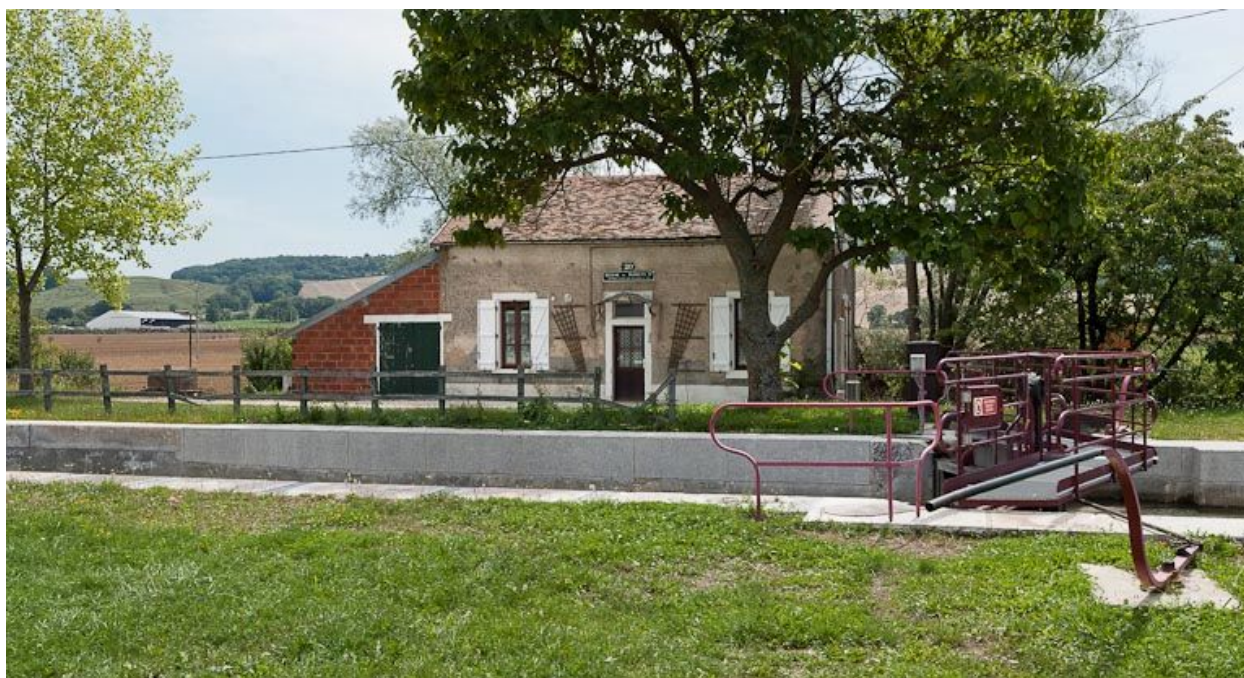
Vue de face de la maison éclusière.
