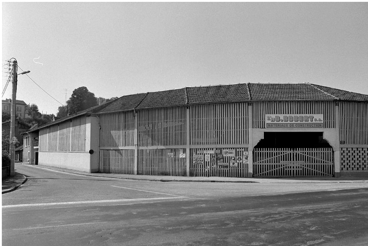
Vue d'ensemble des entrepôts depuis la rue.
