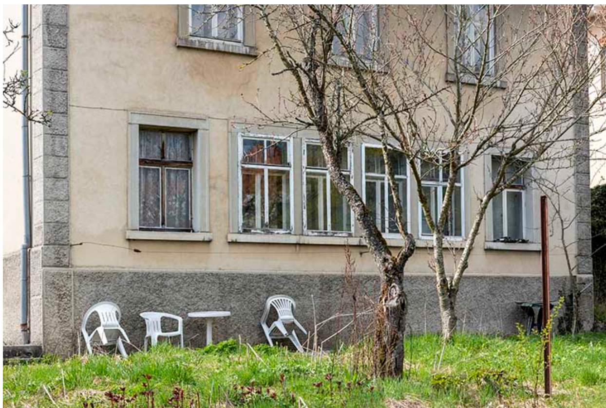
Façade postérieure : fenêtres multiples de l'atelier.
