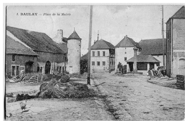
Vue de la place principale depuis la rue Grande, avec la maison commune et école, la fontaine-colonne, le lavoir.
