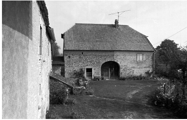
Vue principale. Phot. Bernard Lardière IVR43_19797000021Z
