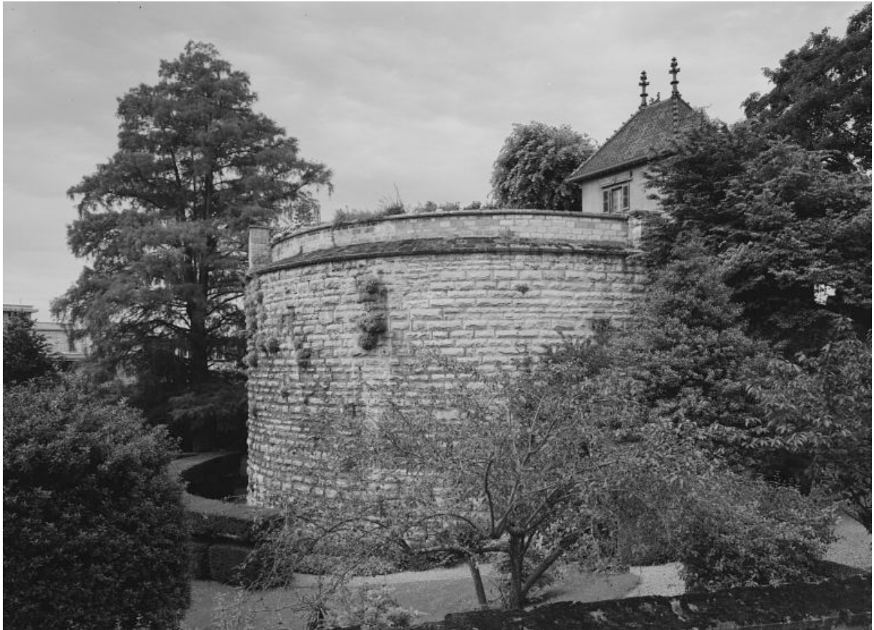
Tour sud-est depuis la rue du Château (1988).
