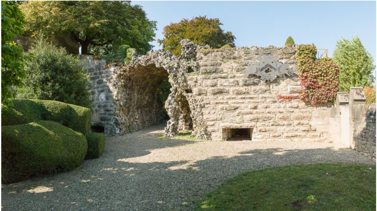
Passage aménagé dans l'ancienne courtine.
