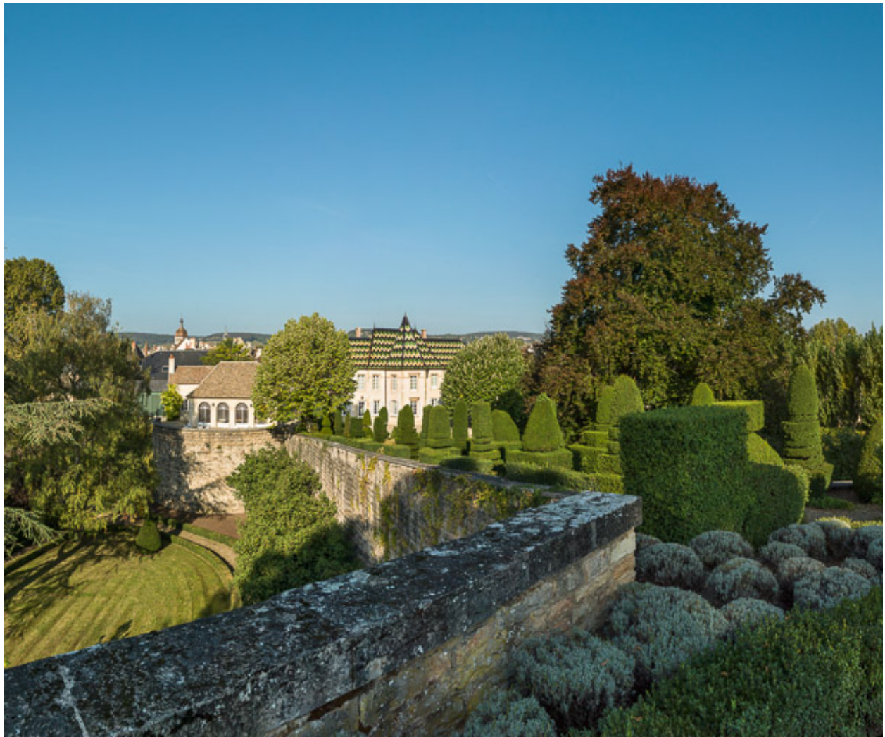
La rampe depuis le belvédère.
