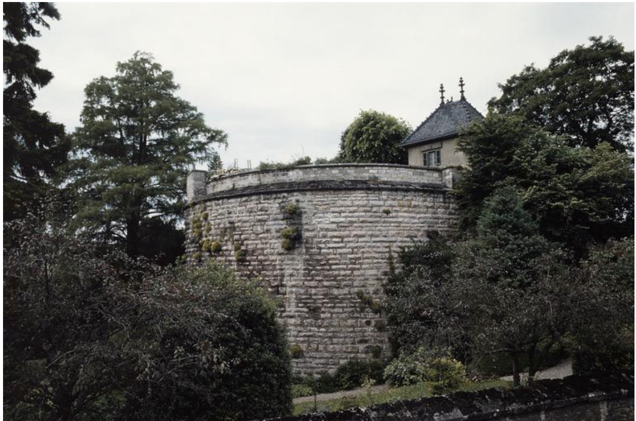
Tour sud-est depuis la rue du Château (1988).
