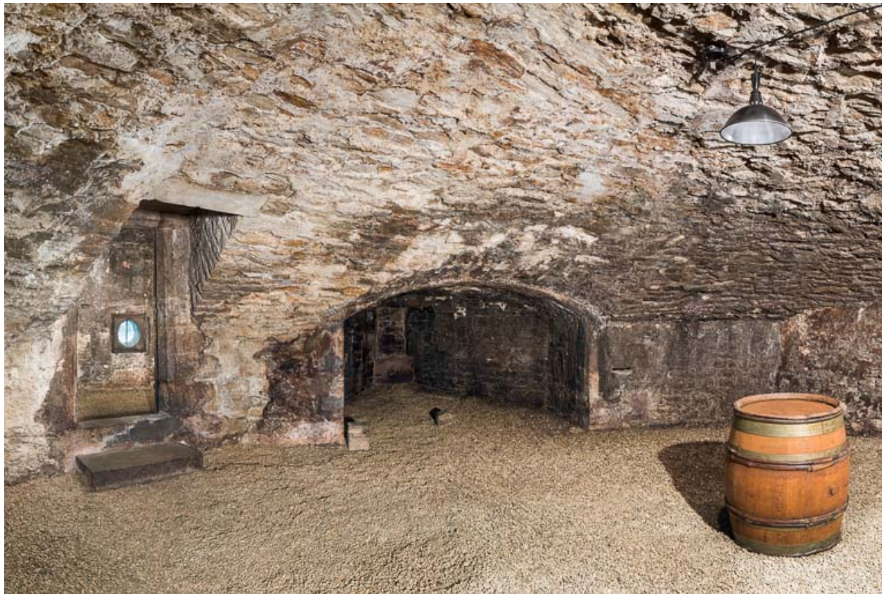
Casemate inférieure de la tour sud-ouest.
