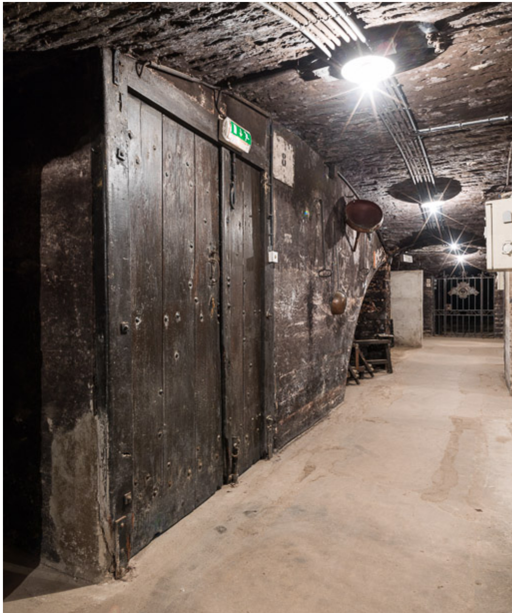
Porte d'accès vers les anciens chais.
