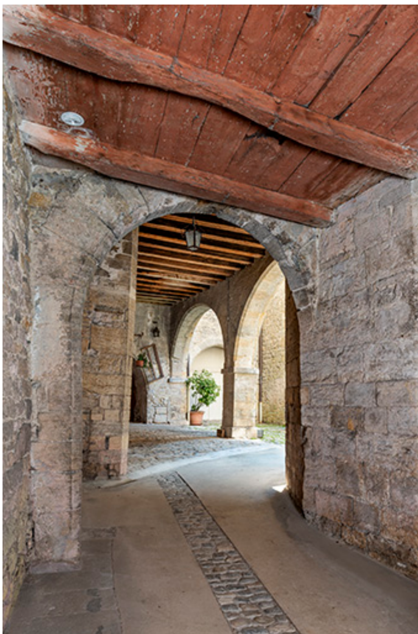
Pemière cour vue depuis l'entrée.
