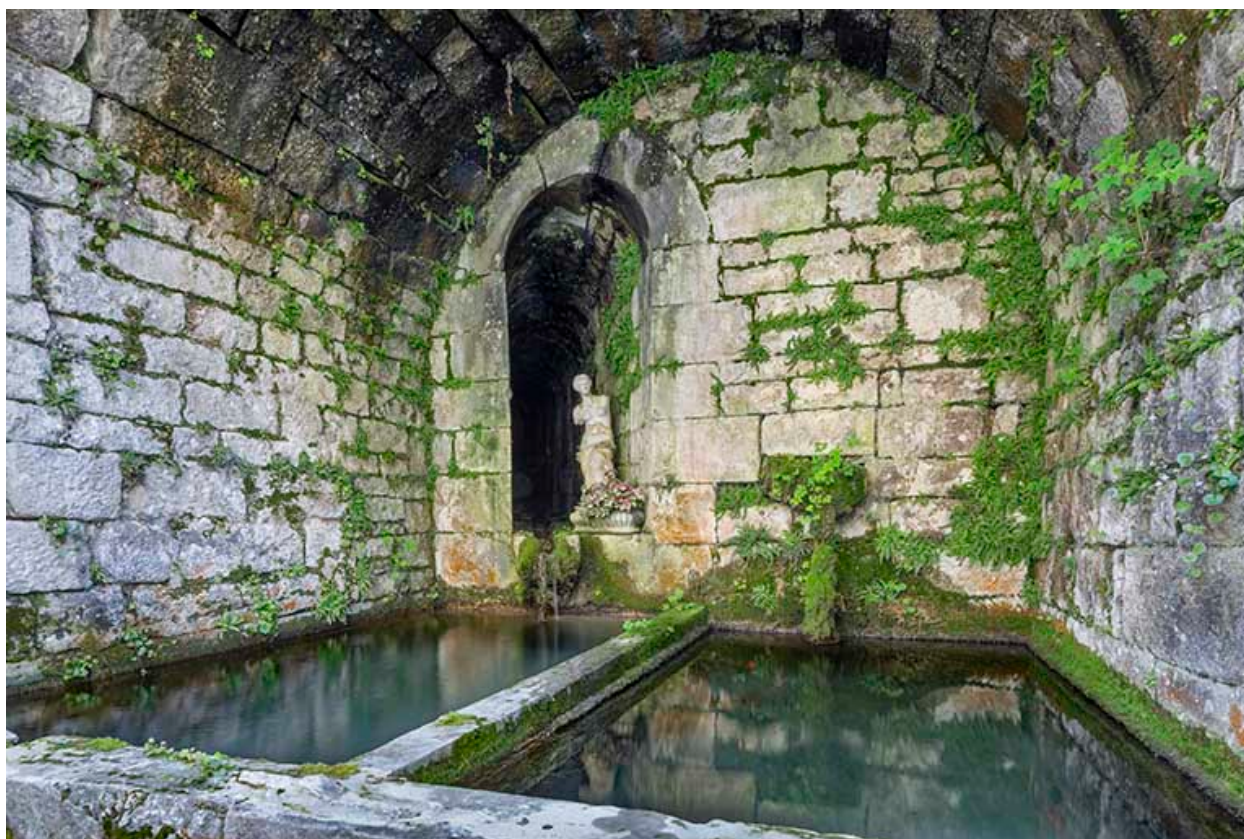
Détail du vivier et du conduit d'amenée.
