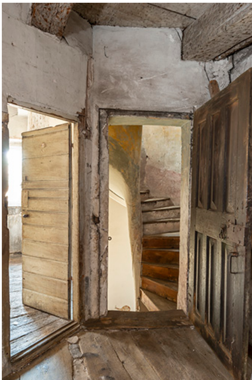
Entrée du couloir depuis la tour polygonale.
