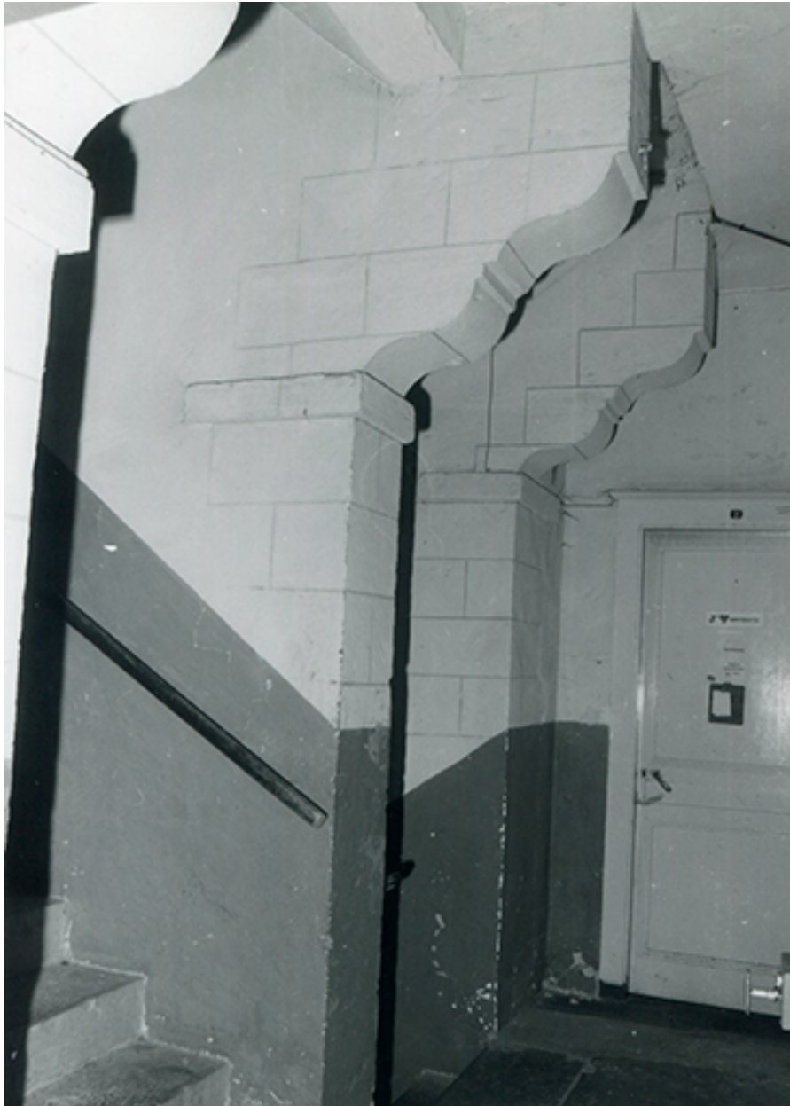
Consoles de l'escalier du couvent, 1985.
