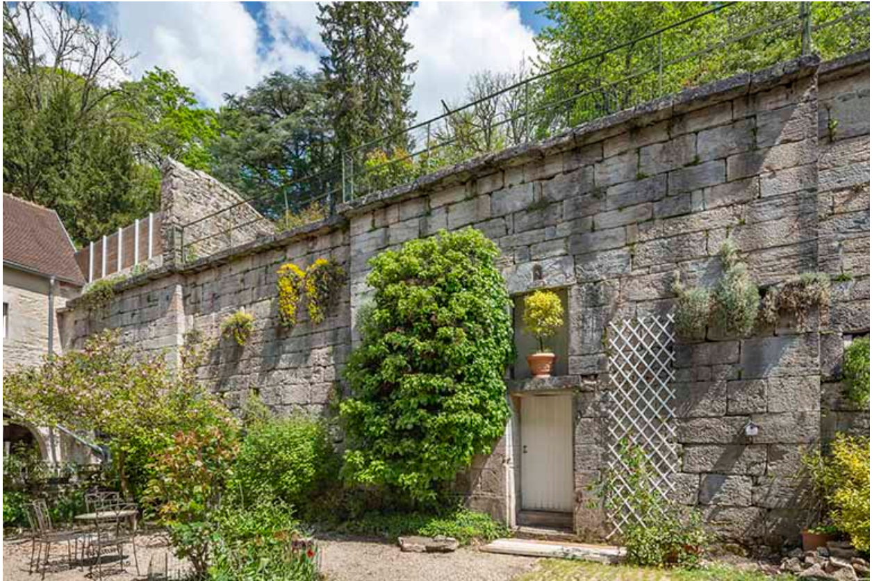
Mur de la terrasse en terre-plein.
