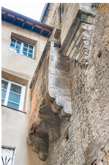
Bretèche et partie en encorbellement sur le mur nord du bâtiment sur rue. Phot. Jérôme Mongreville IVR43_20233900382NUC4A
