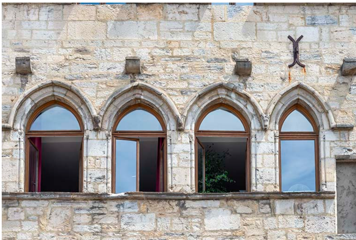
Façade antérieure. Baies du deuxième étage.
