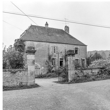
Vue de la partie habitation. Phot. Dominique Dominguez IVR43_19807000134X
