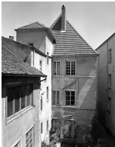
Façade postérieure et aile sur cour. Phot. Yves Sancey IVR43_19917000114X
