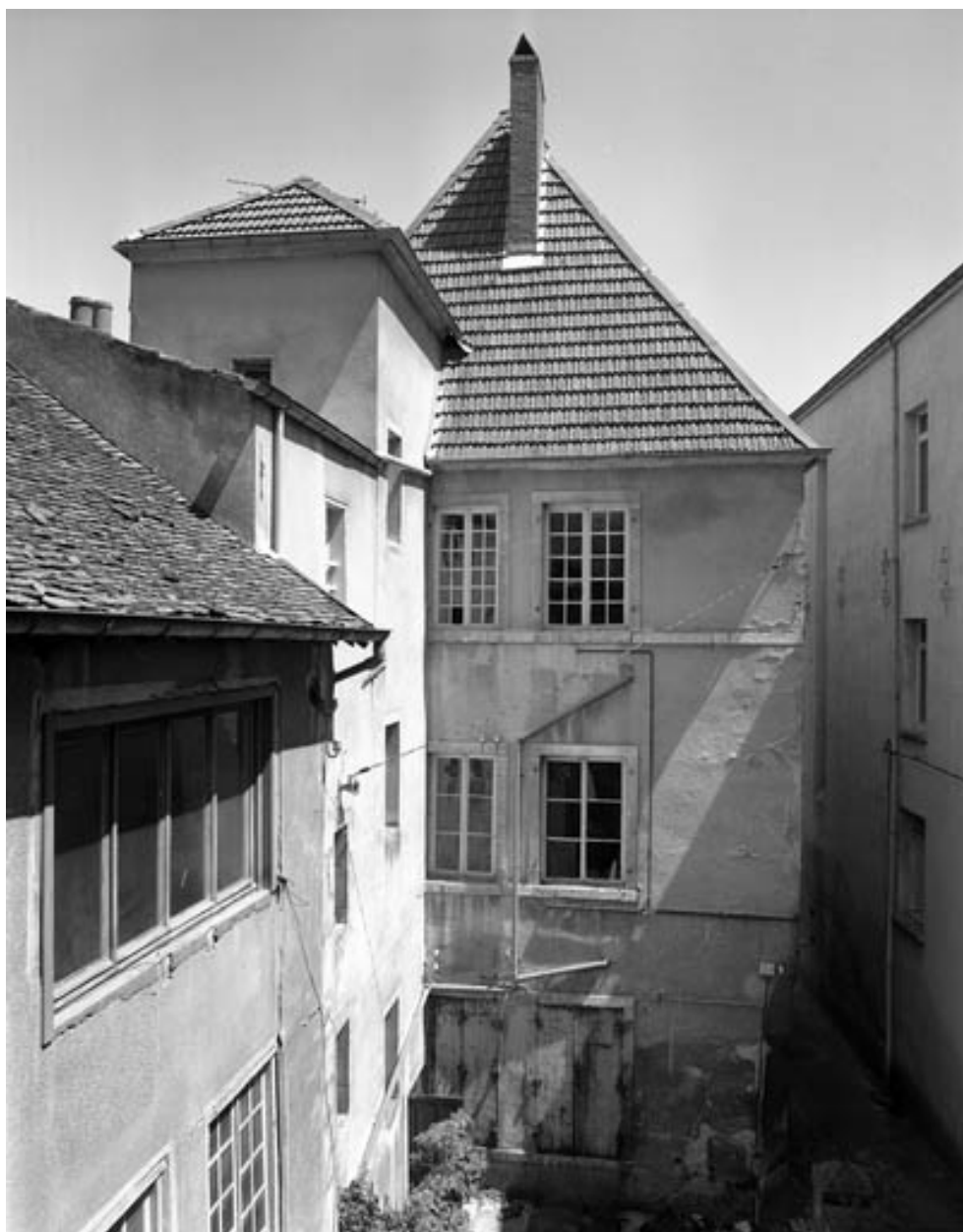
Façade postérieure et aile sur cour.
