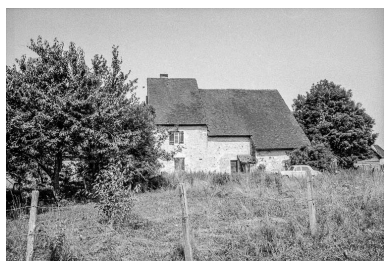
Façade postérieure en 1975. Phot. Bernard Pontefract IVR43_19753900398Z
