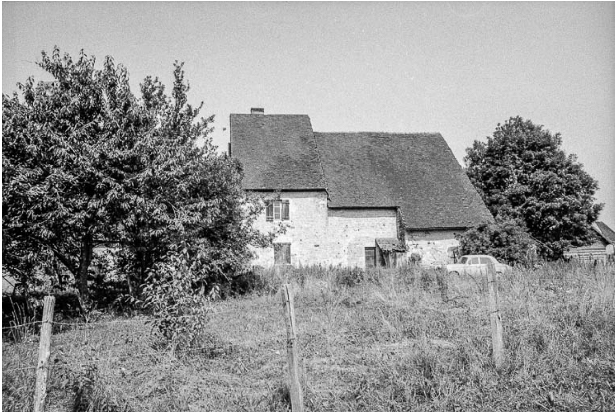
Façade postérieure en 1975.
