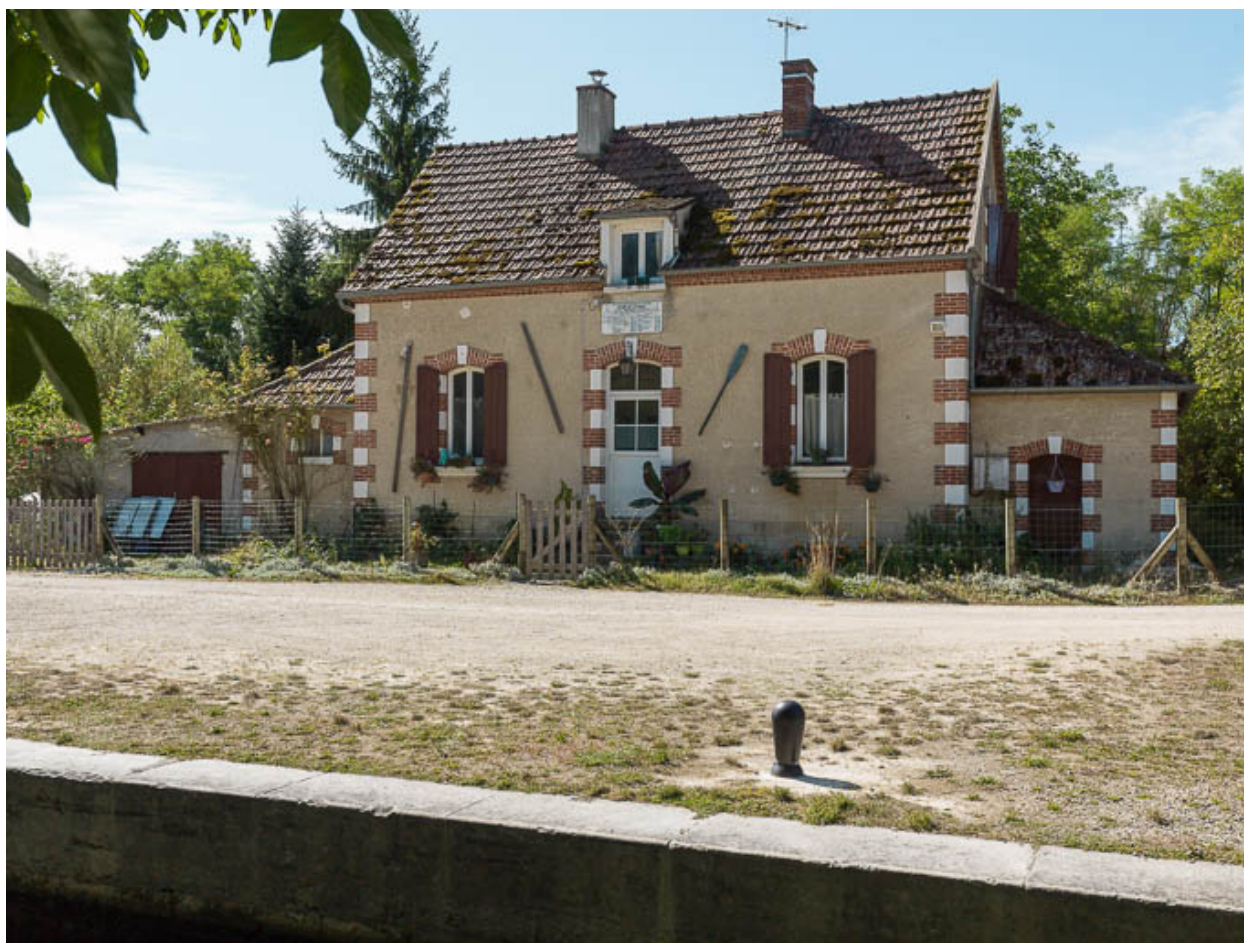
Vue de la maison éclusière.
