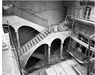
Escalier sur cour intérieure. Phot. Yves Sancey IVR43_19812500132X
