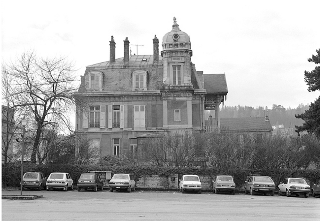
Façade latérale droite.
