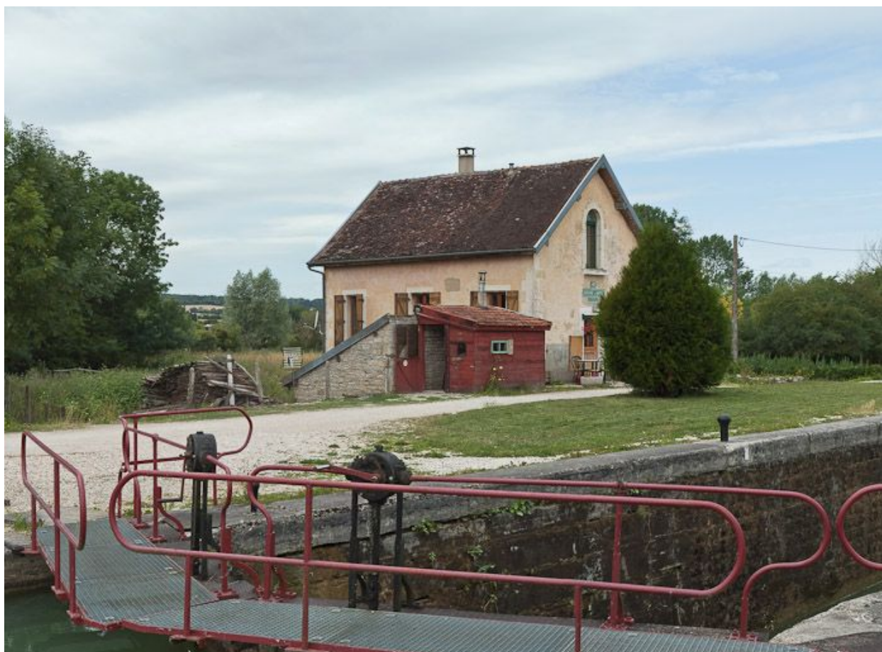
Vue d'ensemble du site d'écluse.
