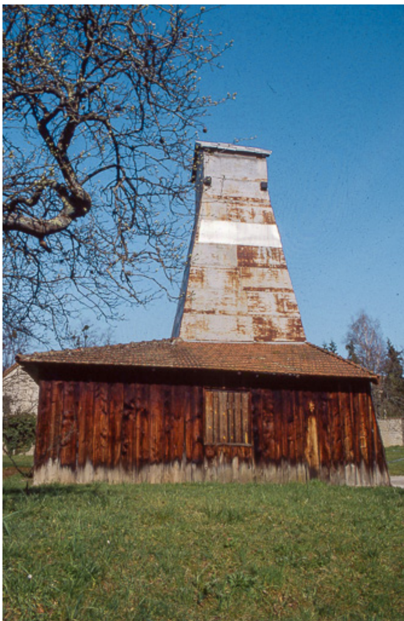
Puits de sondage nord : vue de côté.
