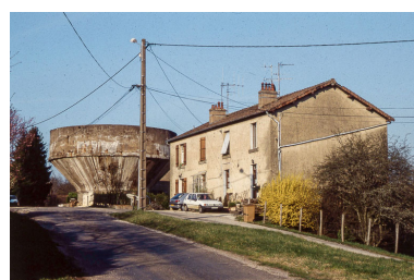
Réservoir industriel (saumure) et logement d'ouvriers. Phot. Yves Sancey IVR43_19992500040ZA
