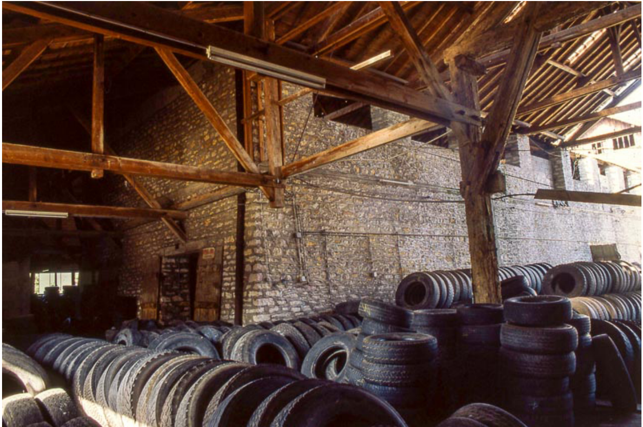
Charpente du quai et magasin industriel.
