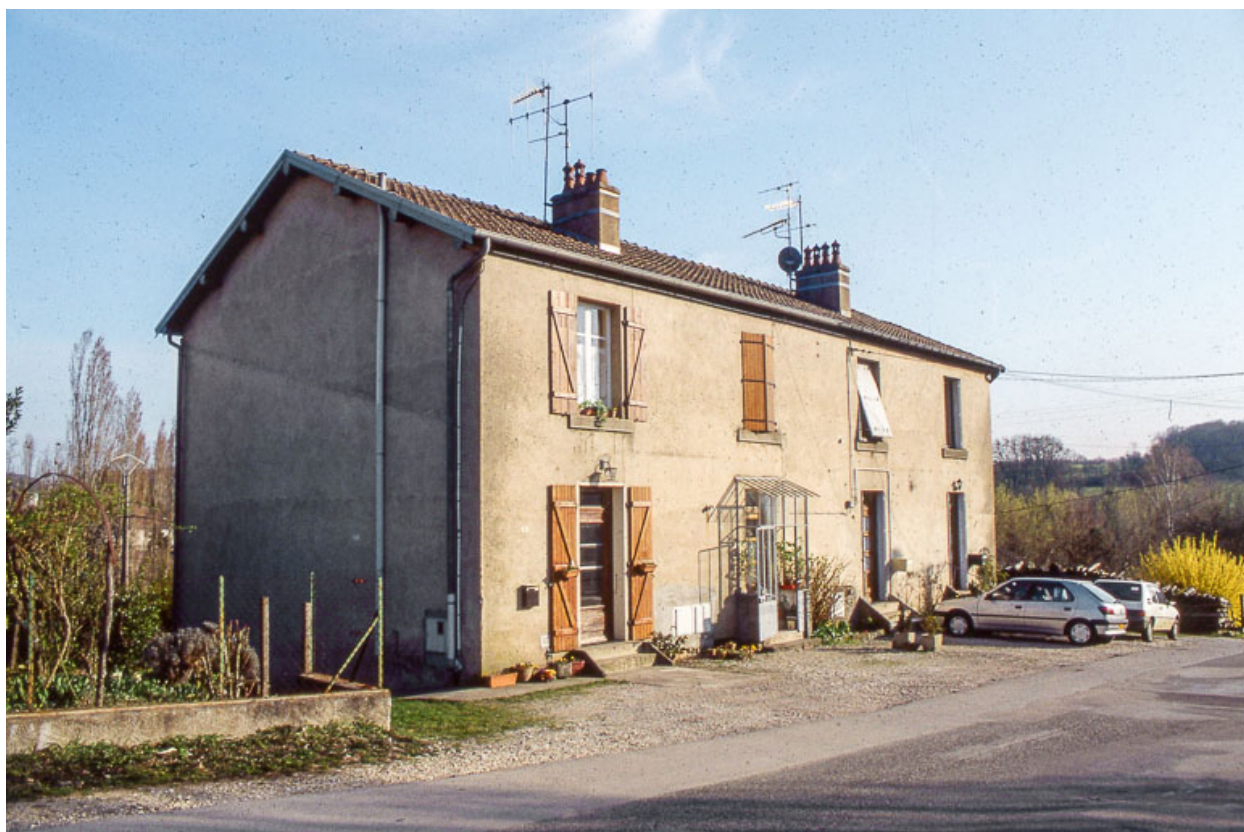
Logement d'ouvriers (9 rue des Saulniers).
