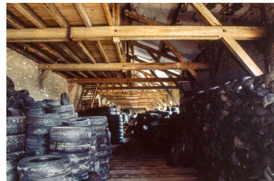
Intérieur d'un quai couvert. Phot. Yves Sancey IVR43_19992500030ZA
