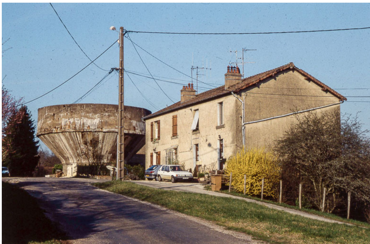
Réservoir industriel (saumure) et logement d'ouvriers.
