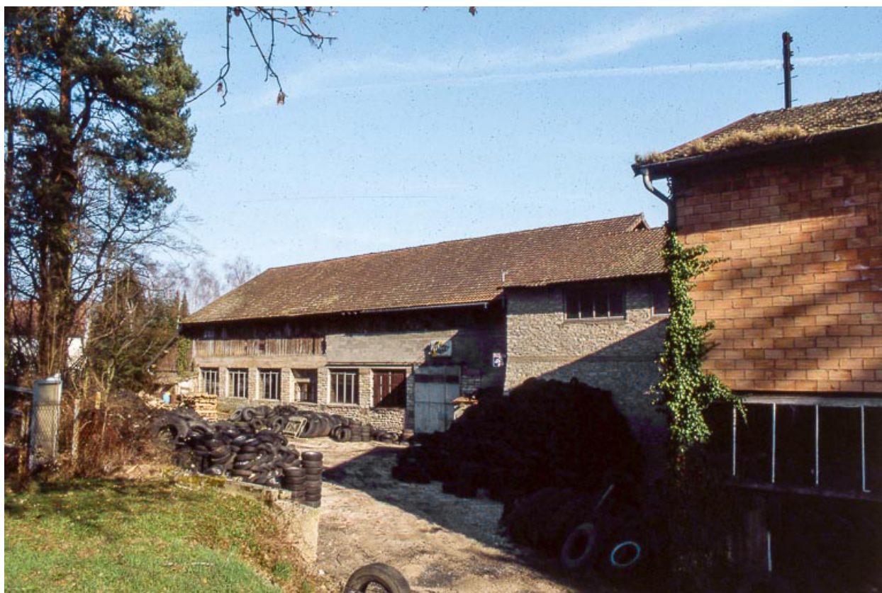
Façades occidentales des magasins industriels.
