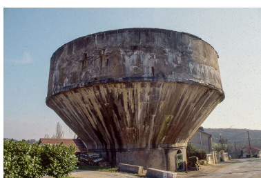
Réservoir industriel (depuis le nord). Phot. Yves Sancey
