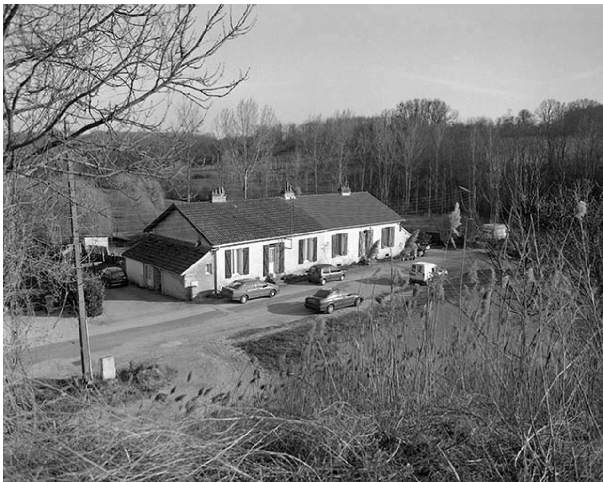
Logement d'ouvriers (19 rue des Saulniers).
