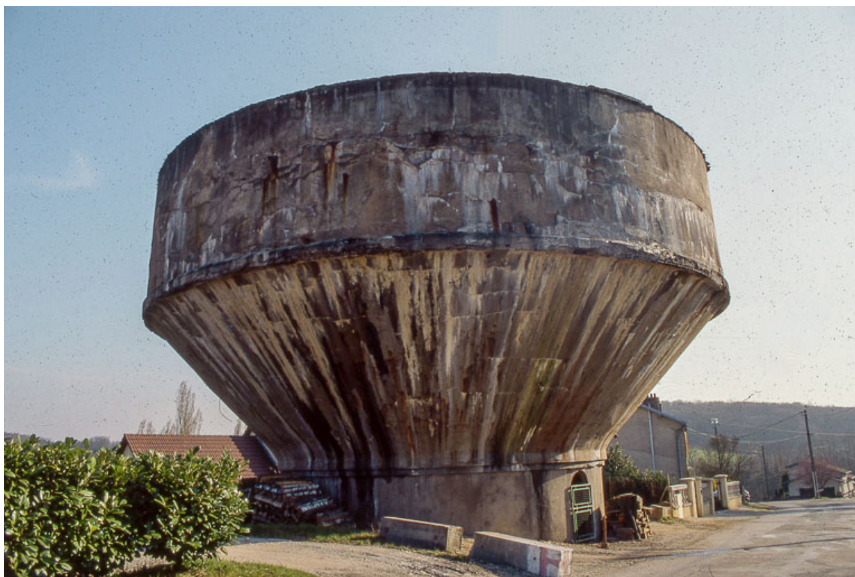
Réservoir industriel (depuis le nord).
