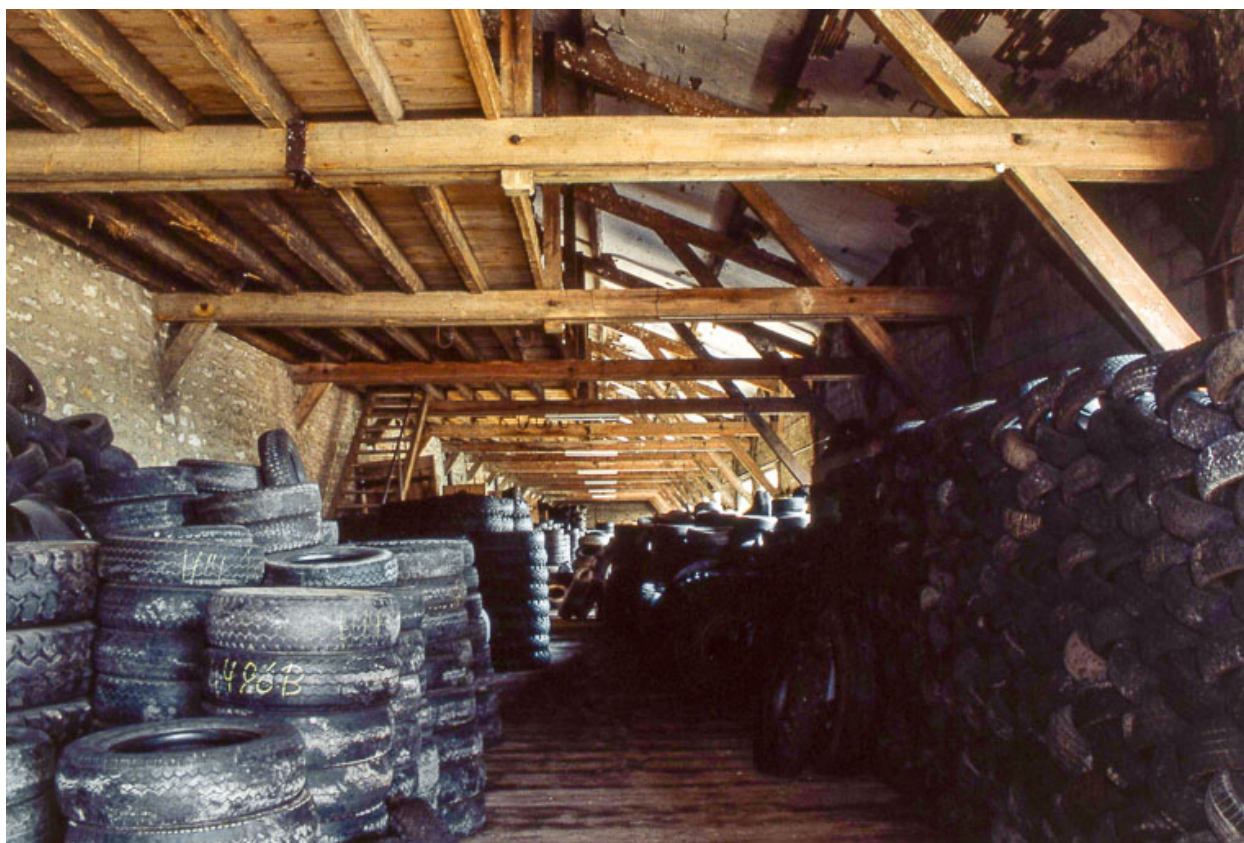
Intérieur d'un quai couvert.
