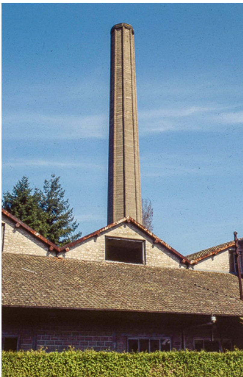
Quai couvert, magasins industriels et cheminée.
