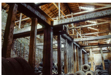
Intérieur d'un magasin industriel. Phot. Yves Sancey IVR43_19992500032ZA
