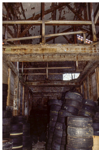
Intérieur d'un magasin industriel. Phot. Yves Sancey IVR43_19992500034ZA
