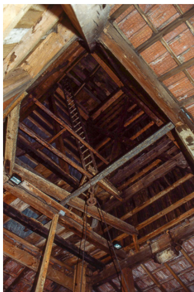
Puits de sondage nord : intérieur
