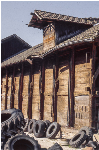
Détail de façade d'un magasin industriel. Phot. Yves Sancey IVR43_19992500026ZA
