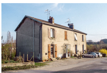
Logement d'ouvriers (9 rue des Saulniers). Phot. Yves Sancey IVR43_19992500042ZA
