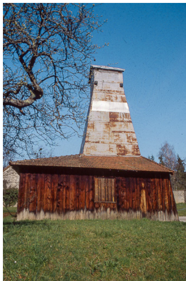
Puits de sondage nord : vue de côté.
