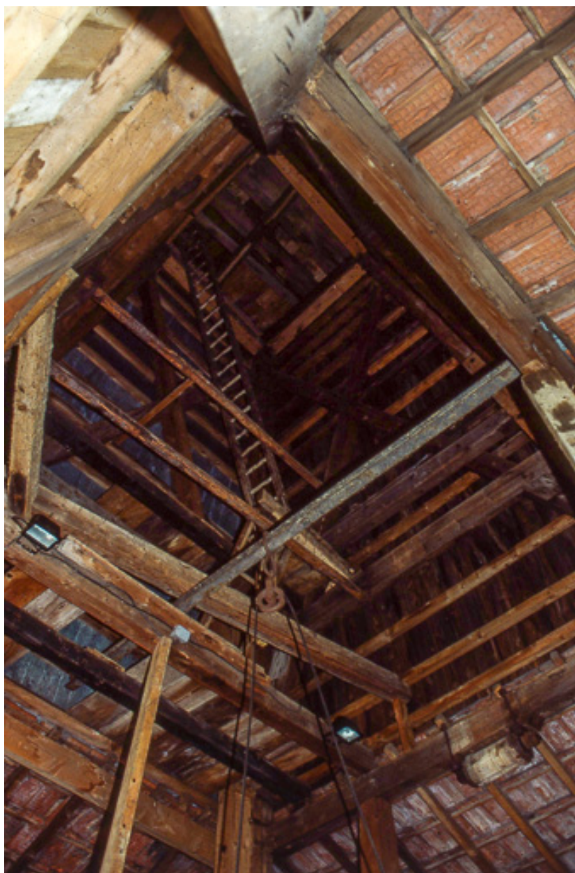
Puits de sondage nord : intérieur
