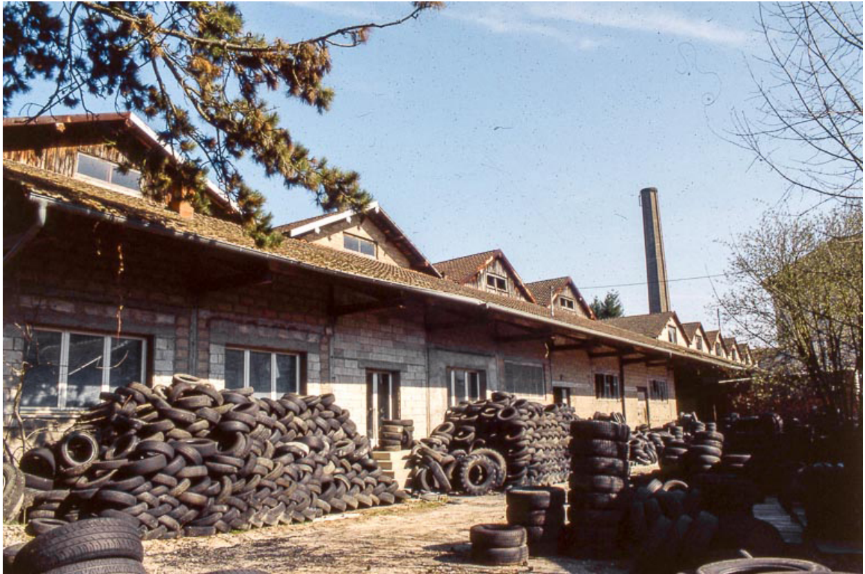
Quai couvert et magasins industriels depuis l'ouest.
