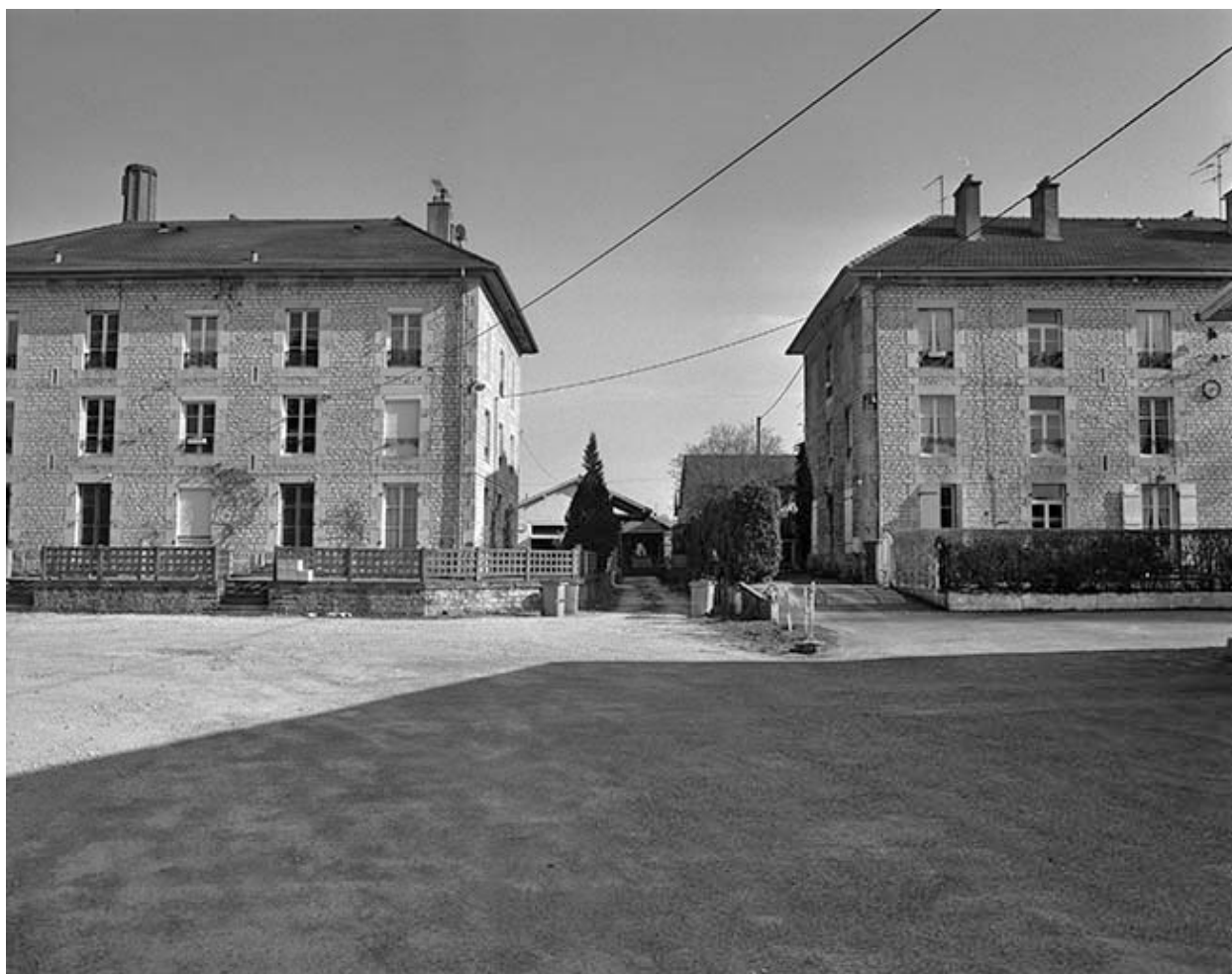
Bâtiments à usage de logements et de bureaux.
