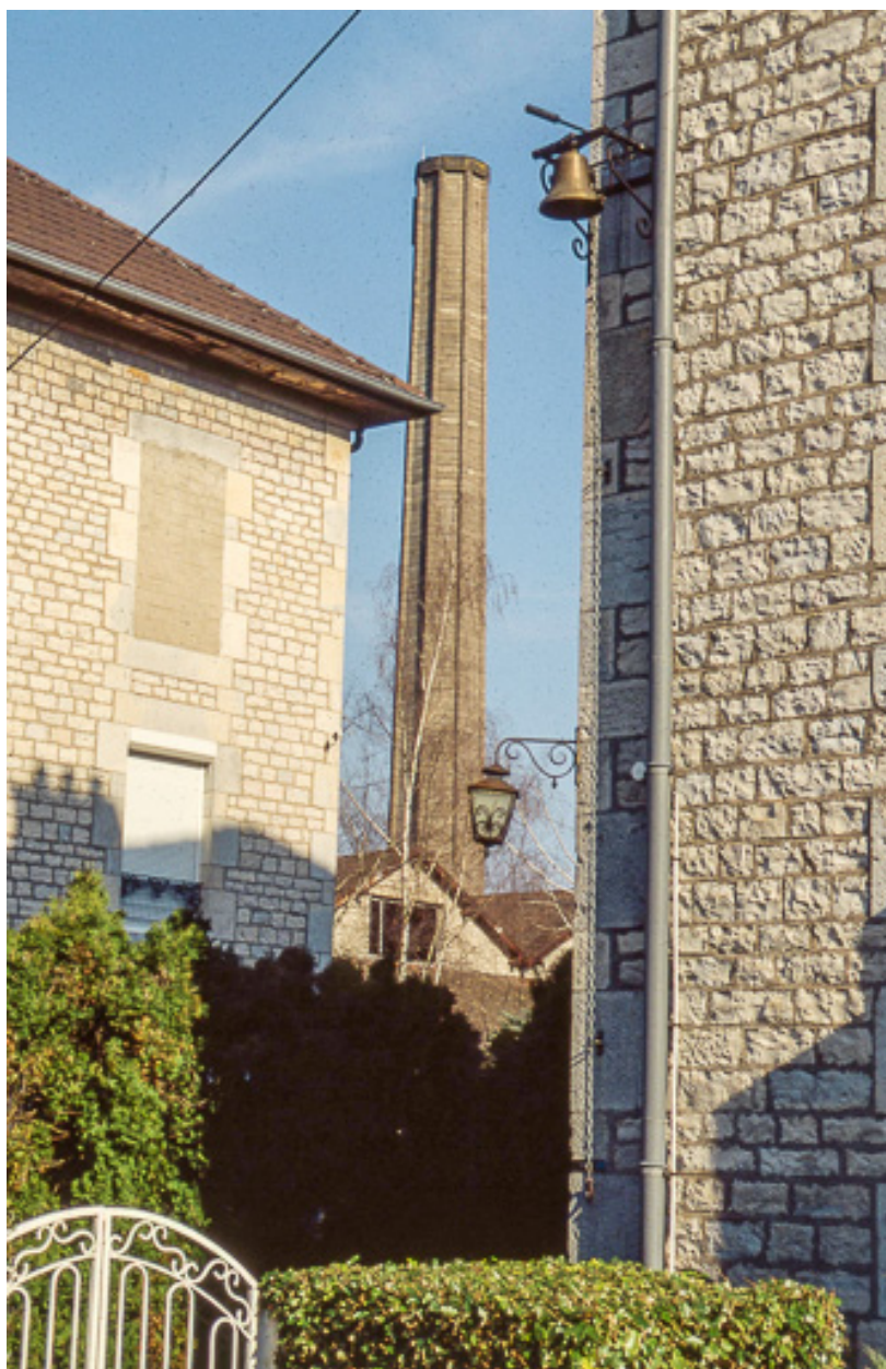
Bureaux, logements et cheminée.
