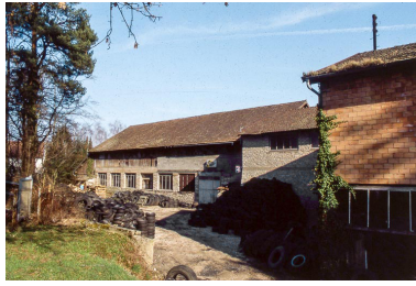
Façades occidentales des magasins industriels. Phot. Yves Sancey IVR43_19992500021ZA
