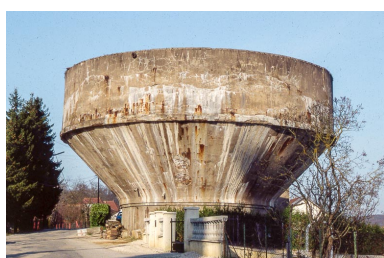
Réservoir industriel. Phot. Yves Sancey
