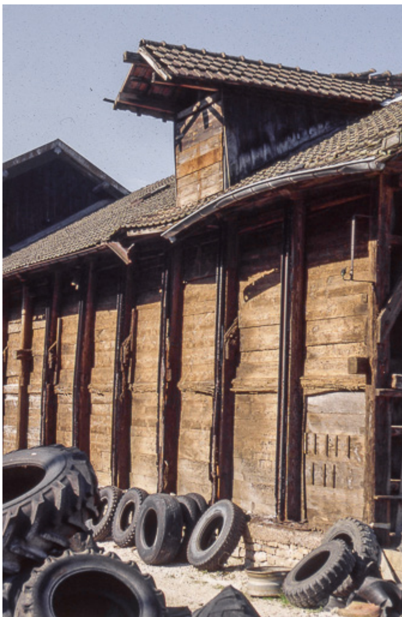
Détail de façade d'un magasin industriel.
