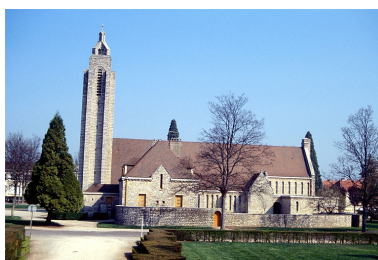
Façade latérale droite. Phot. Laurent Poupard IVR43_19893900447ZA
