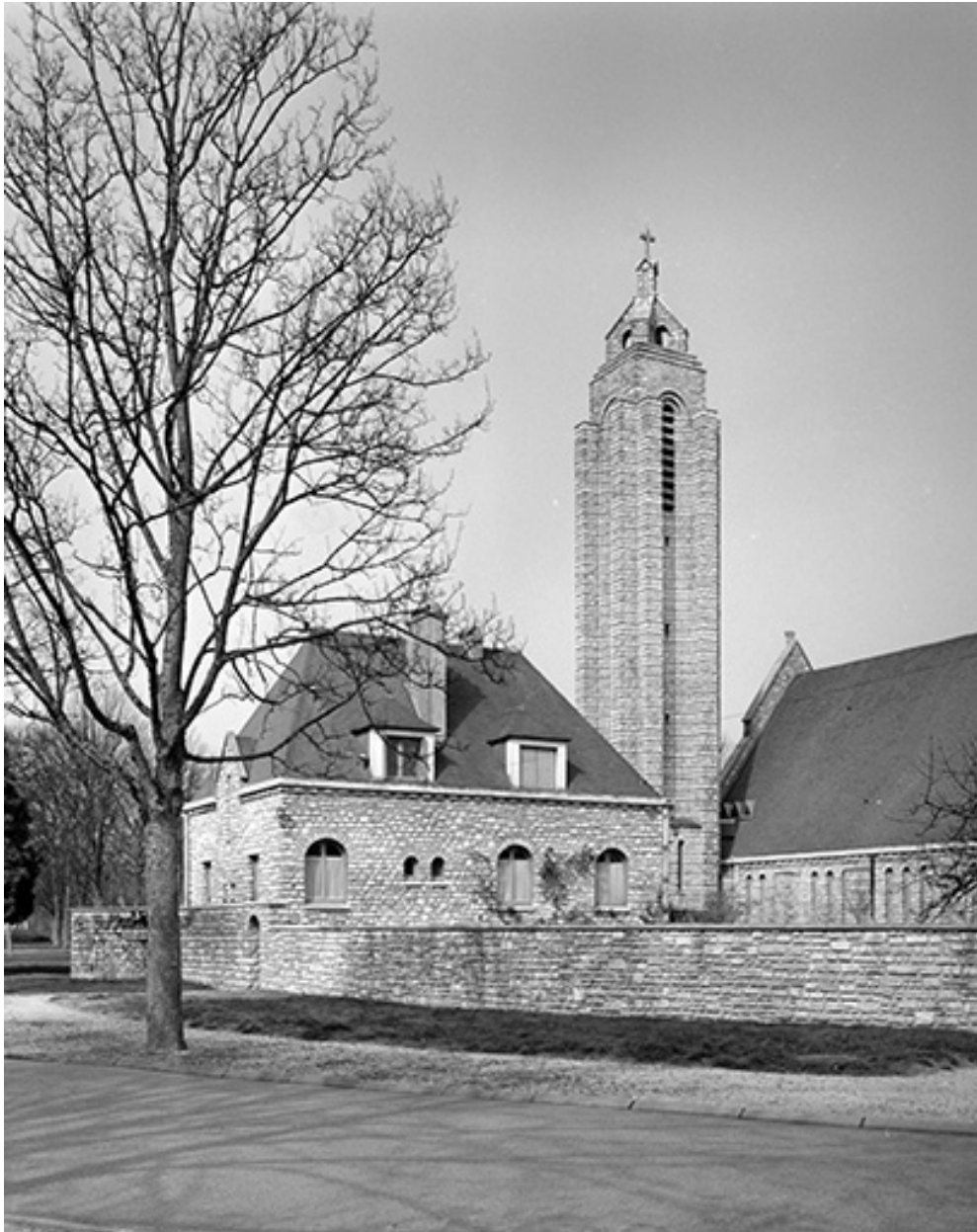
Face postérieure du presbytère et tour-clocher.
