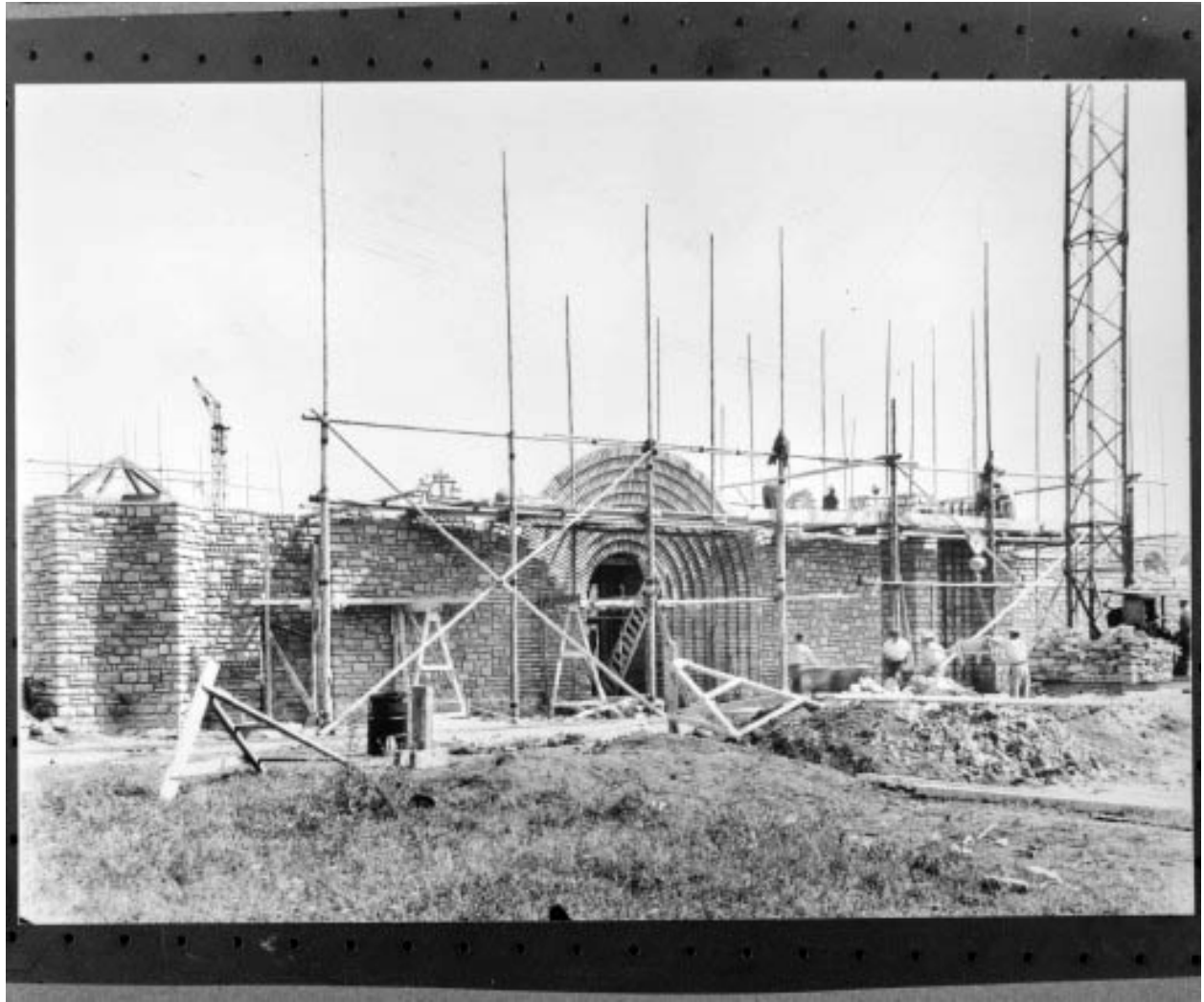
Travaux de construction de l'église, façade ouest.
