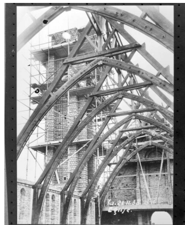
Travaux de construction de l'église, charpente de la nef.
