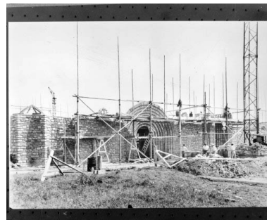
Travaux de construction de l'église, façade ouest.
