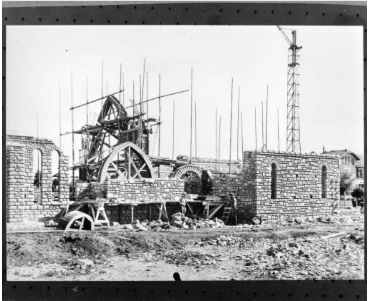
Travaux de construction de l'église, le chevet.
