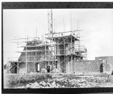
Travaux de construction de l'église, façade ouest.
