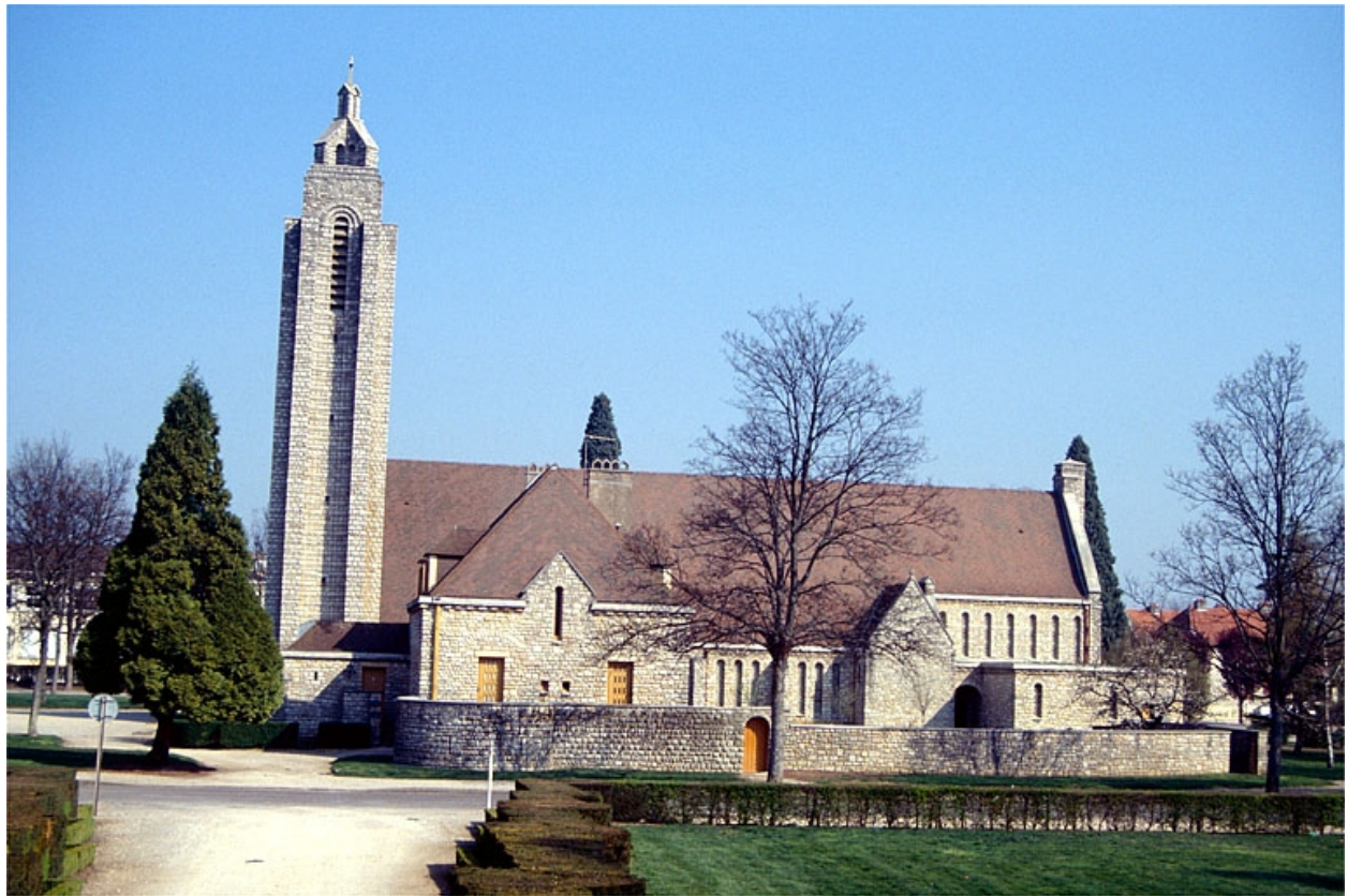
Façade latérale droite.
