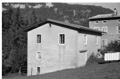
Ancien atelier de fabrication et bureau. Phot. Laurent Poupard IVR43_19903900658Z
