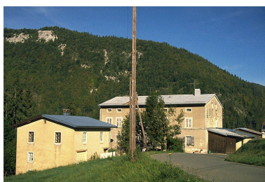
Vue d'ensemble depuis le sud. Phot. Laurent Poupard IVR43_19903900653ZA
