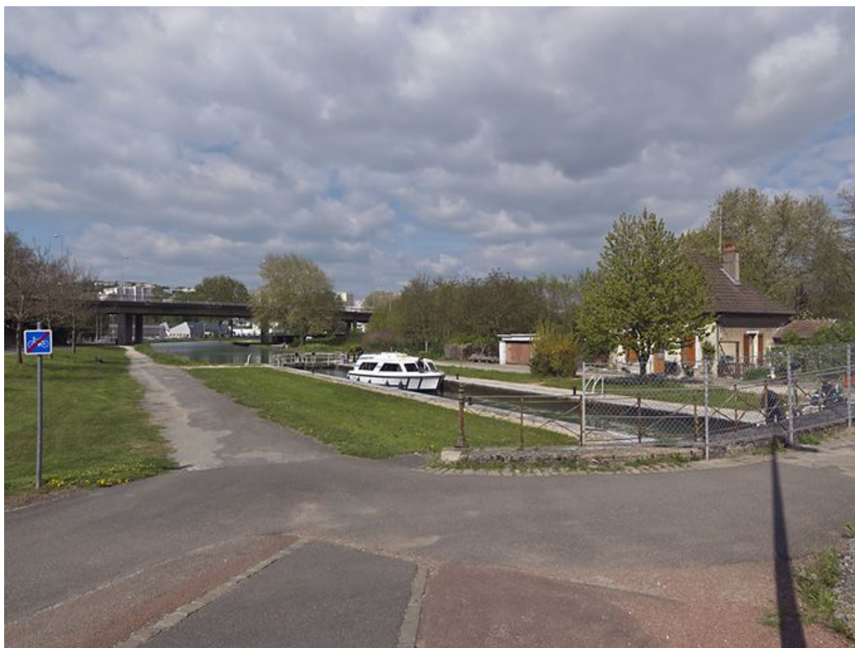
Vue d'ensemble, d'aval.
