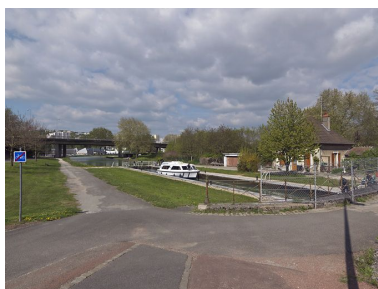
Vue d'ensemble, d'aval.
