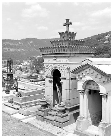
Façades antérieure et latérale droite.
